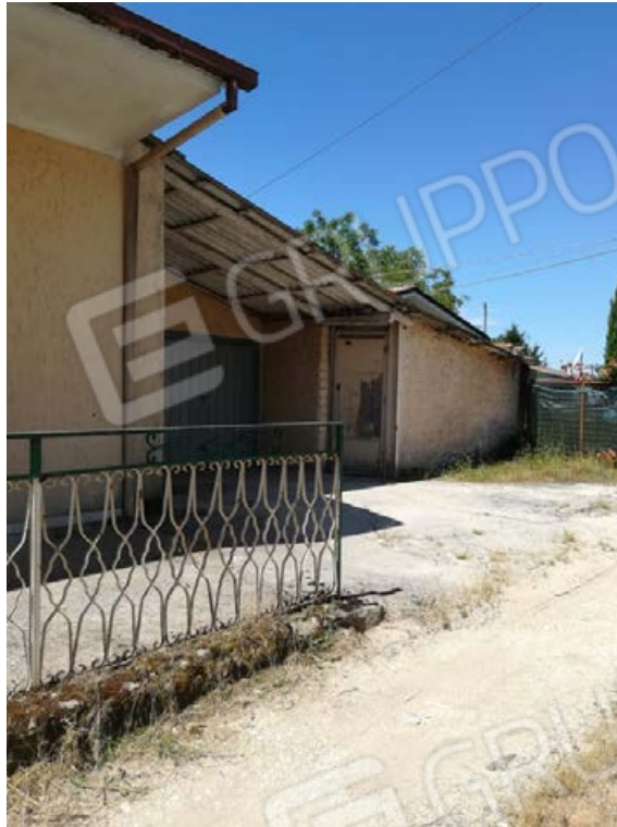
FOTO ESTERNA - IMMOBILE N.1 (mappale 548)
