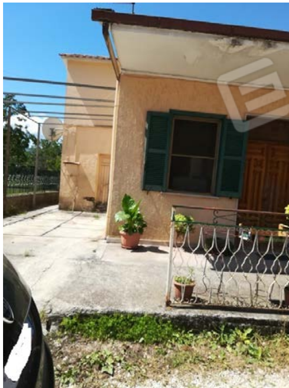
FOTO ESTERNA - IMMOBILE N.1 (mappale 548)
