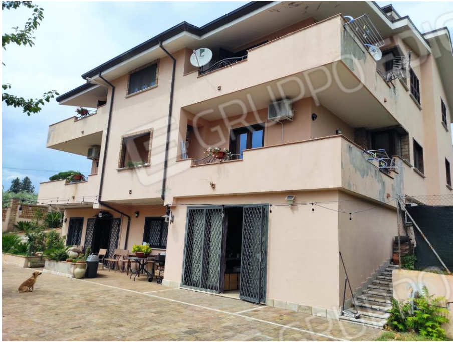
Prospetto laterale del fabbricato in cui sono ubicati i beni oggetto della presente Esecuzione Immobiliare (lato sud). In cui si evince a piano primo sottostrada l'ingresso del bene n. 2 contraddistinto con il sub 5.
