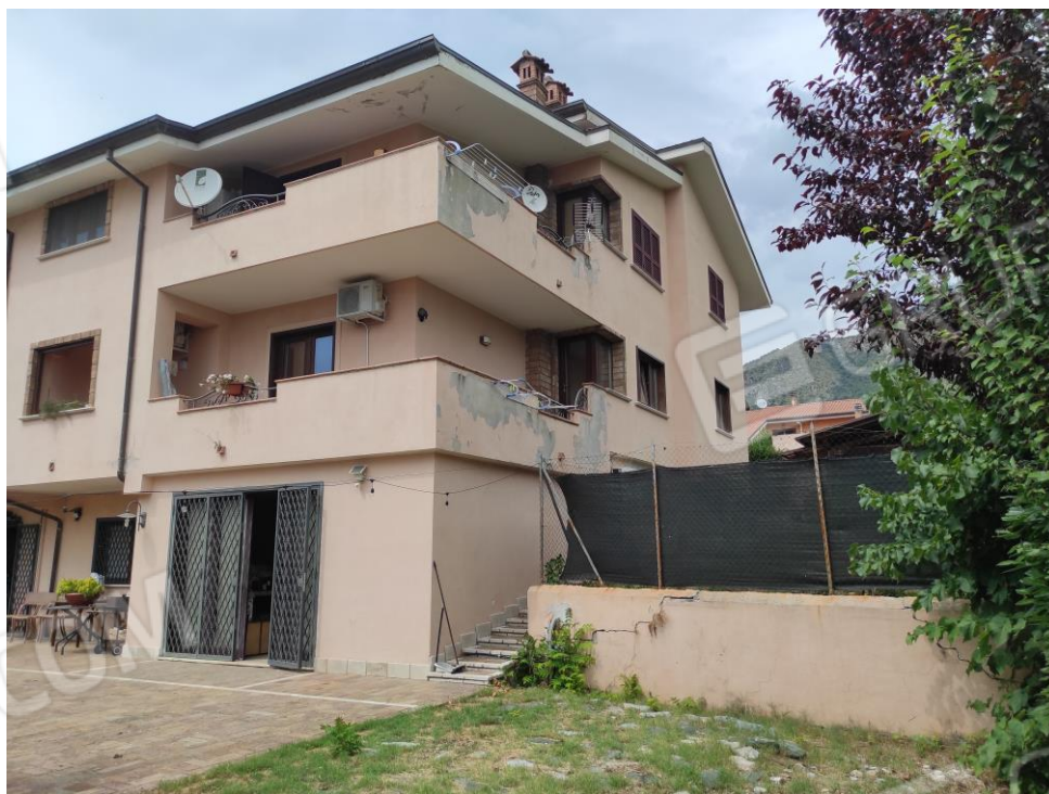
Prospetto laterale del fabbricato in cui sono ubicati i beni oggetto della presente Esecuzione Immobiliare (lato est).
