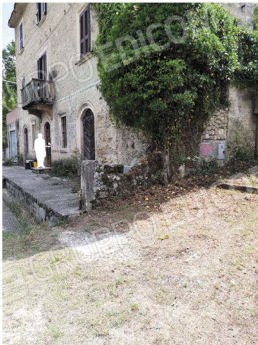
Esterno Facciata sulla strada Comunale
