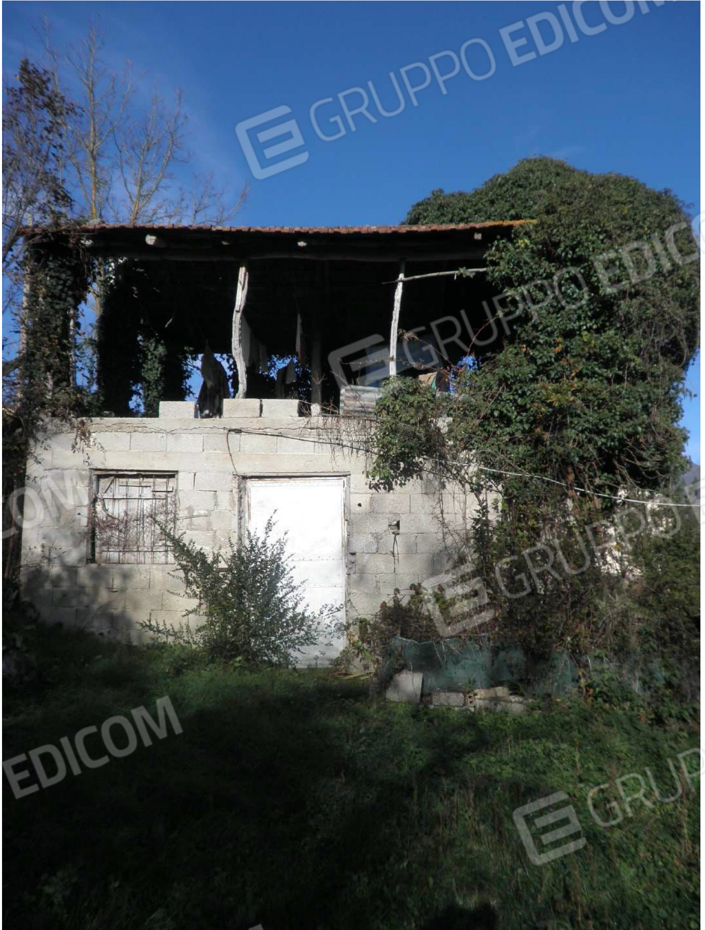
FABBRICATO DIRUPO fg 18 p.IIa 674
