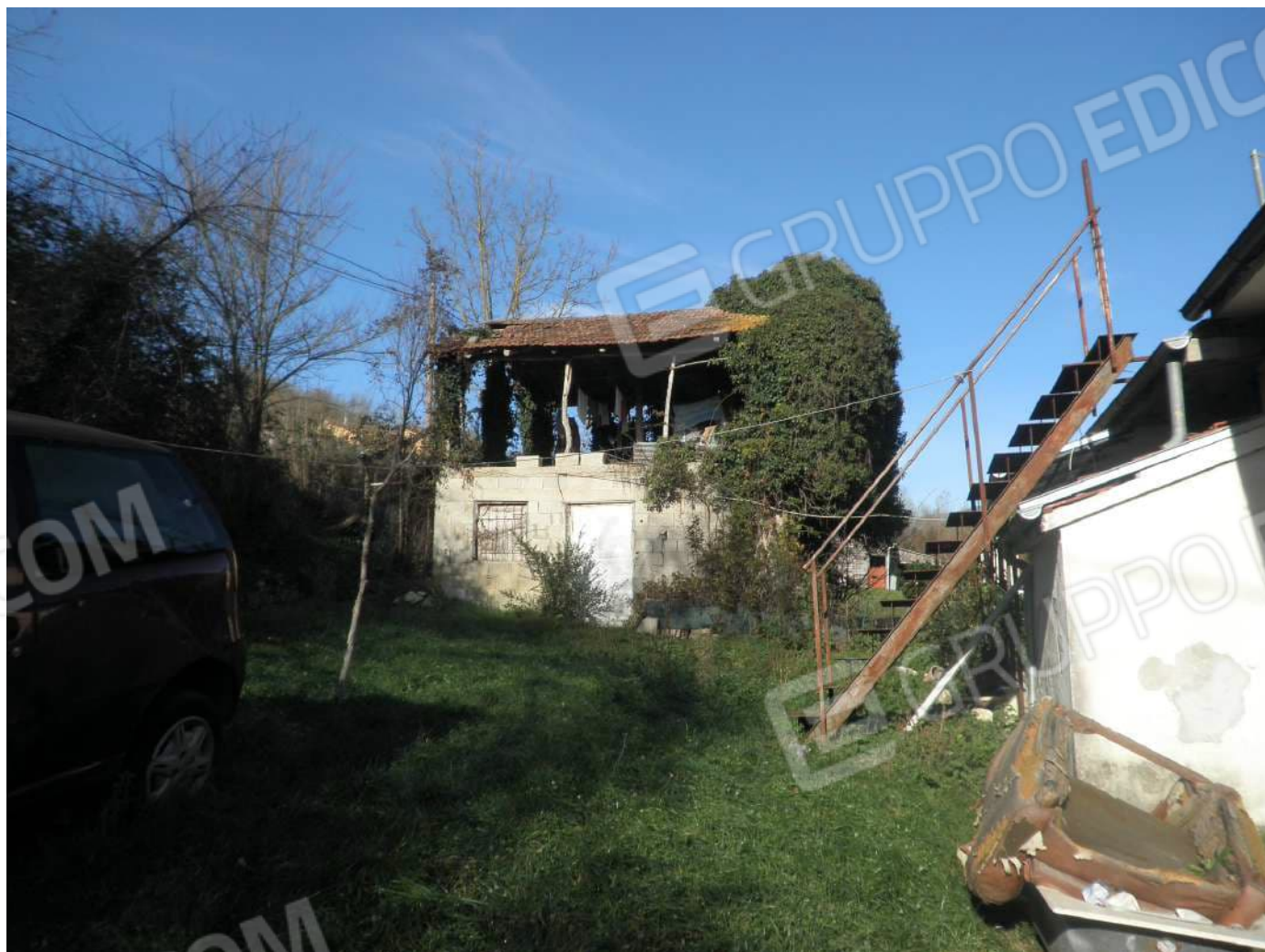
FABBRICATO DIRUPO fg 18 p.IIa 674
