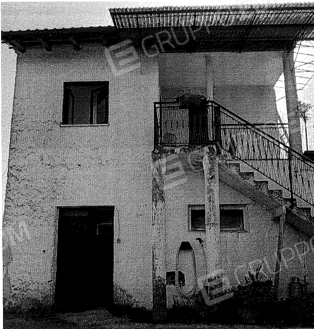
Foto 3. Esterna sub 3 f.24 mapp 511 – Unità collabente, fronte
