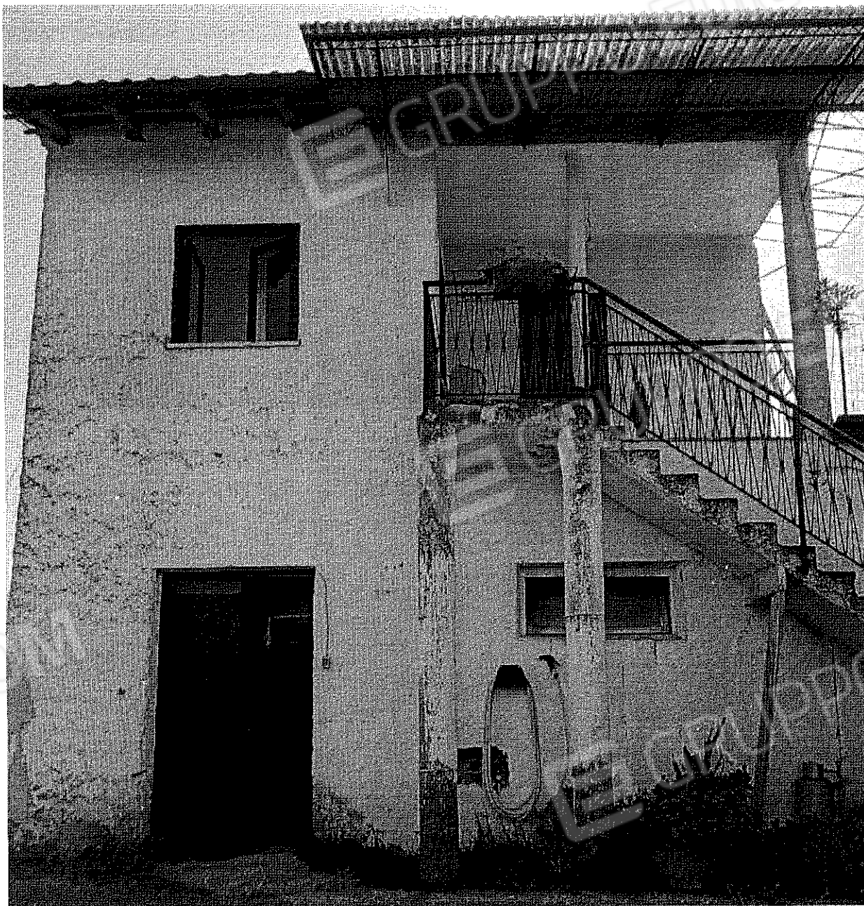
Foto 3. Esterna sub 3 f.24 mapp 511 – Unità collabente, fronte
