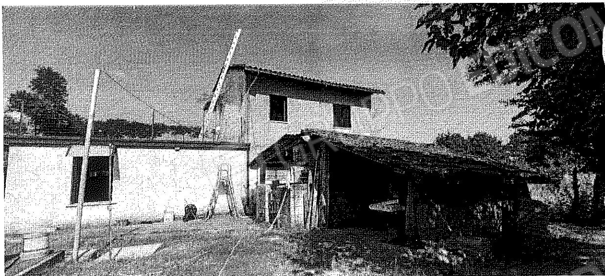
Foto 5. Esterna sub 3 f.24 mapp 511 – Unità collabente, retro
