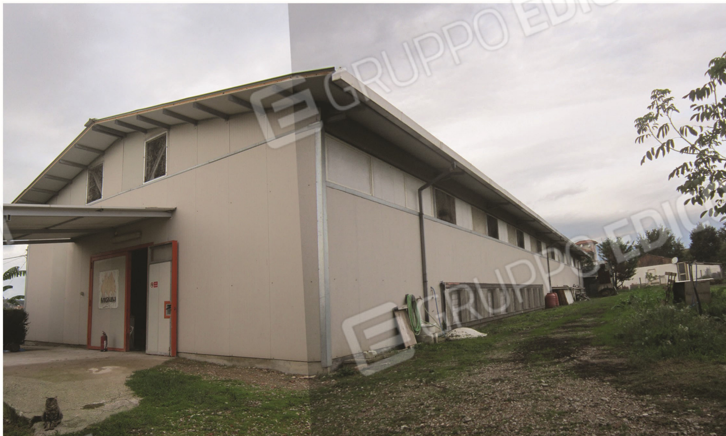
Capannone zootecnico - fg. 61 part. 1025
