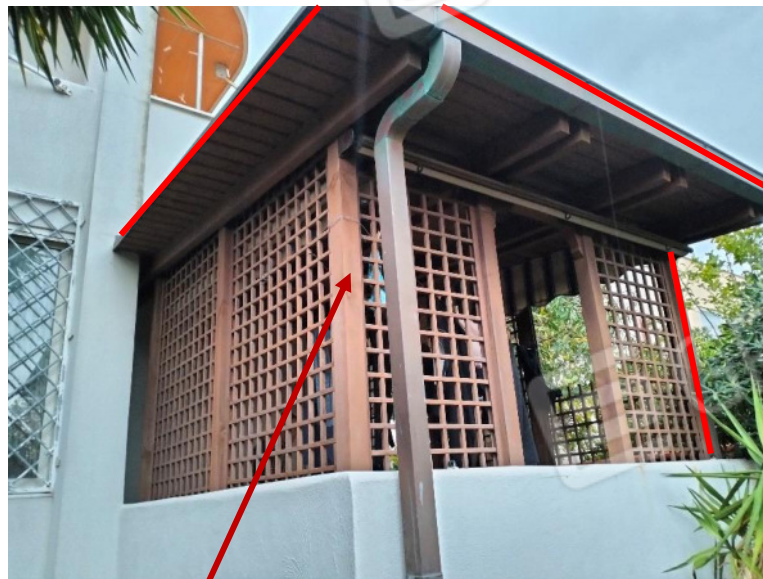
Porticato n. 2 da Demolire
