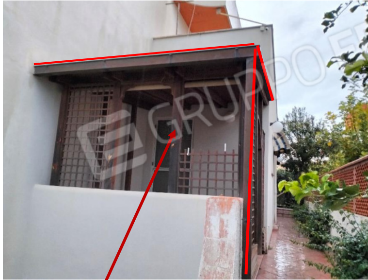
Porticato n. 1 da Demolire
