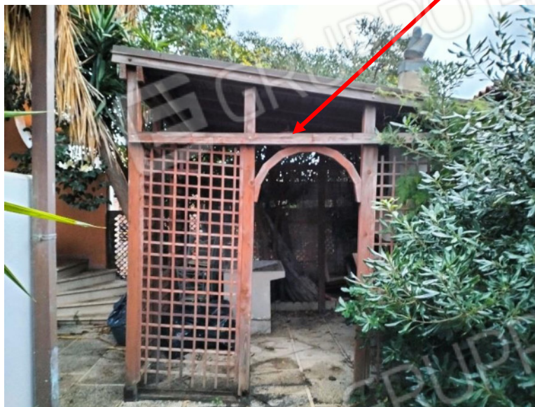
Pergolato da Demolire
