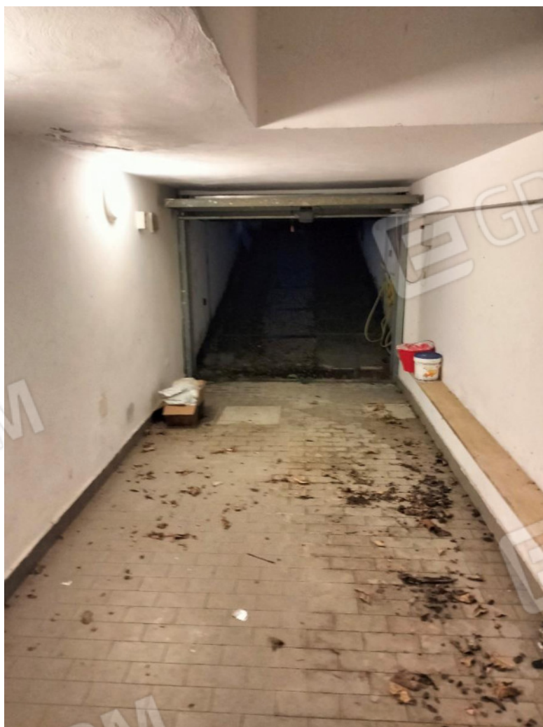
Ingresso Garage Seminterrato
