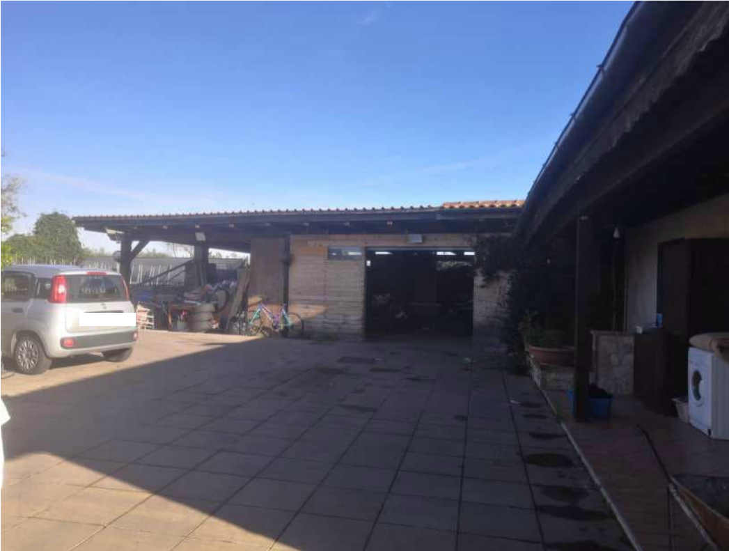
Foto 3 LA TETTOIA DI 64 MQ
