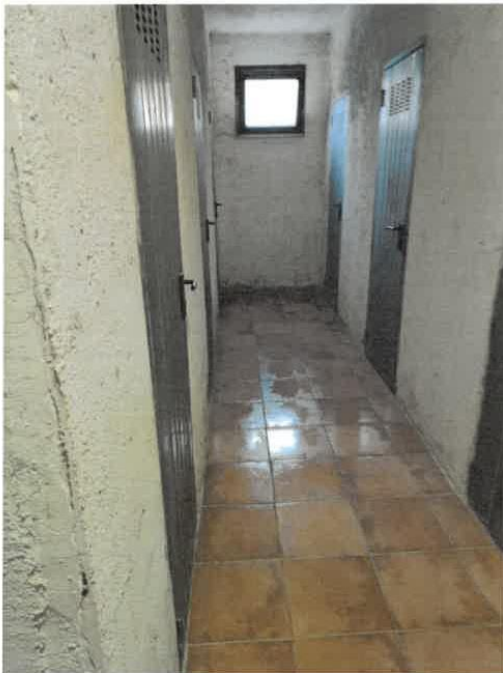
Corridoio di accesso ai locali cantine
