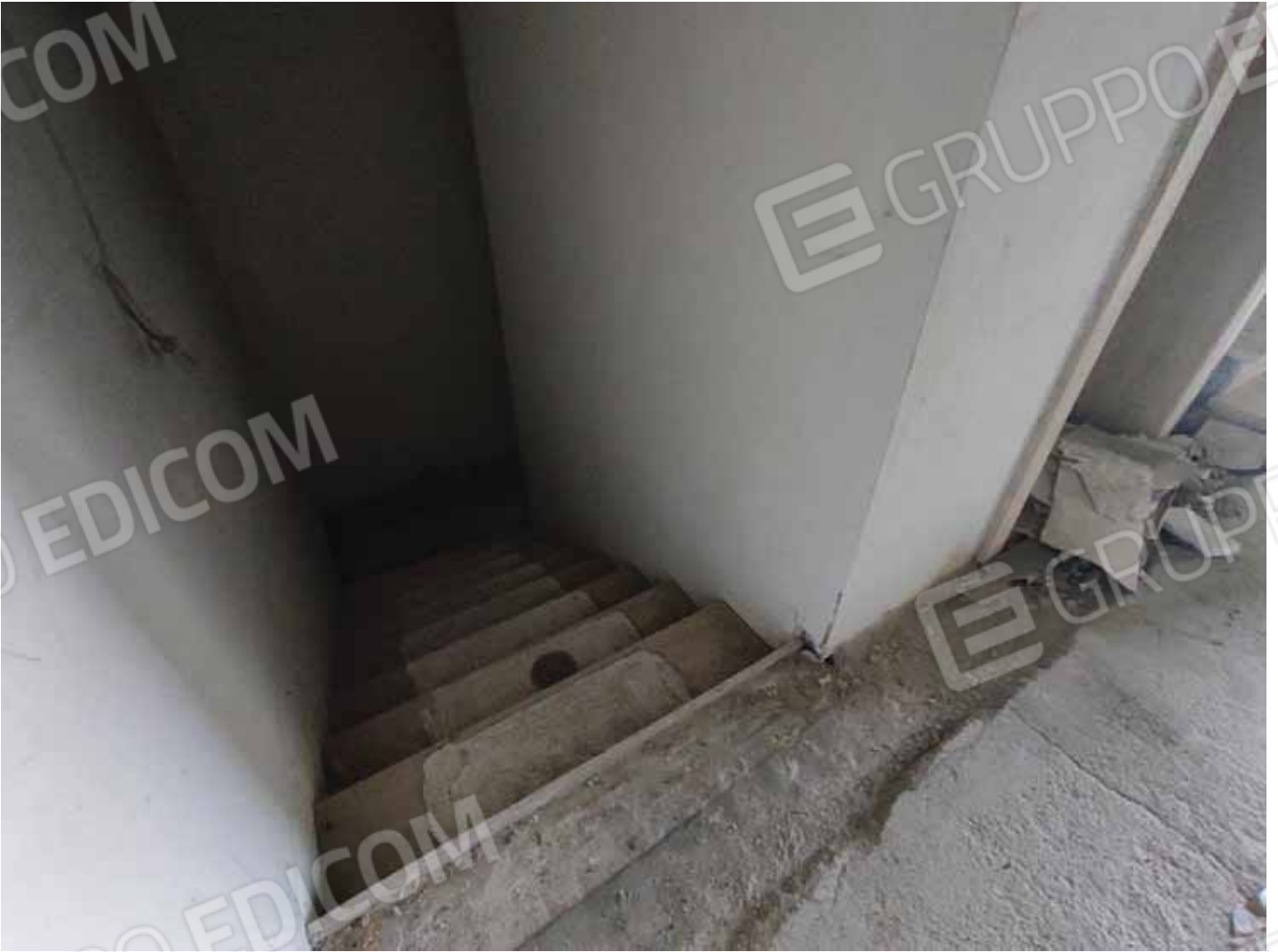
Vano scala verso piano seminterrato
