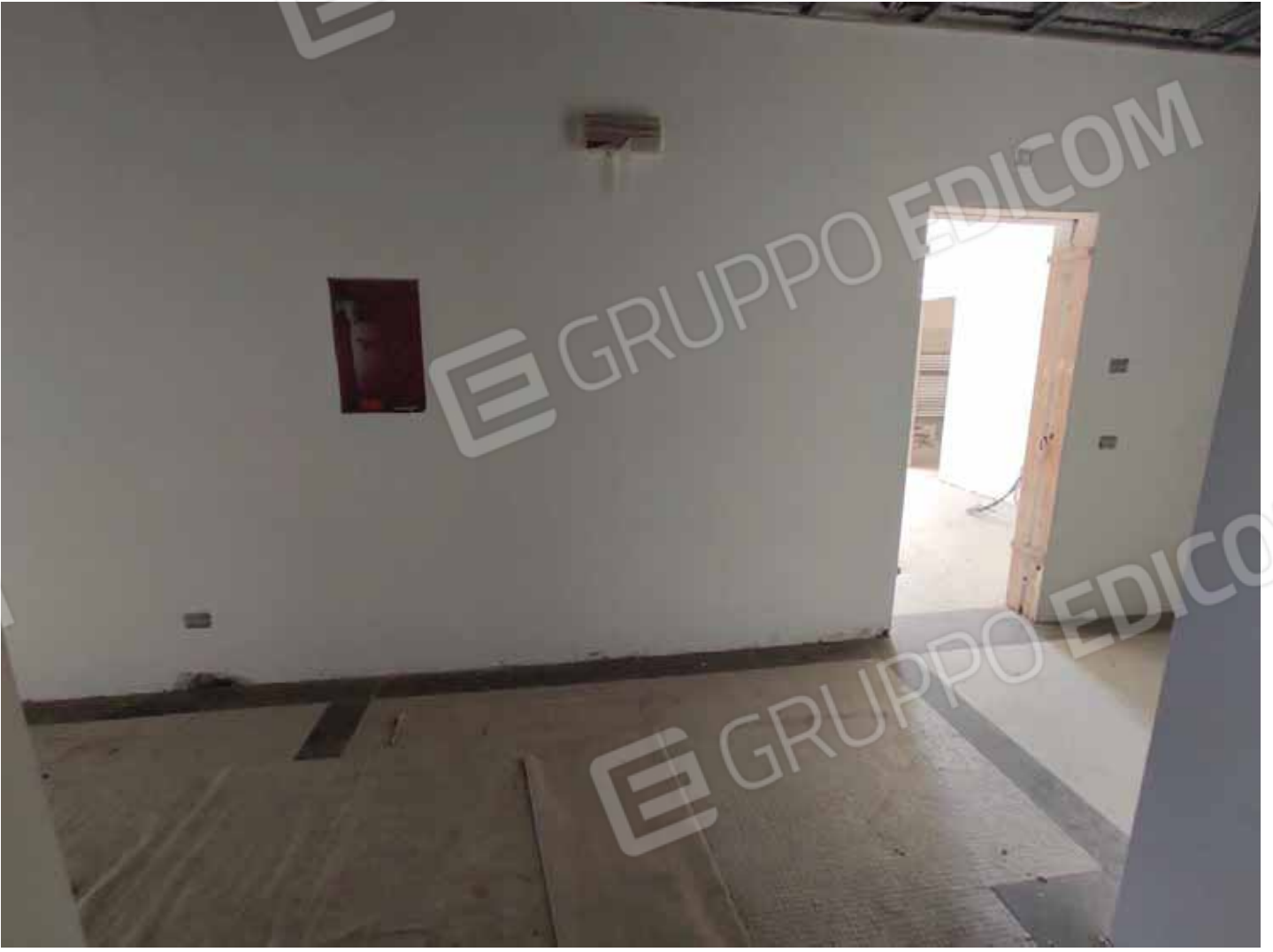
Corridoio piano terra
