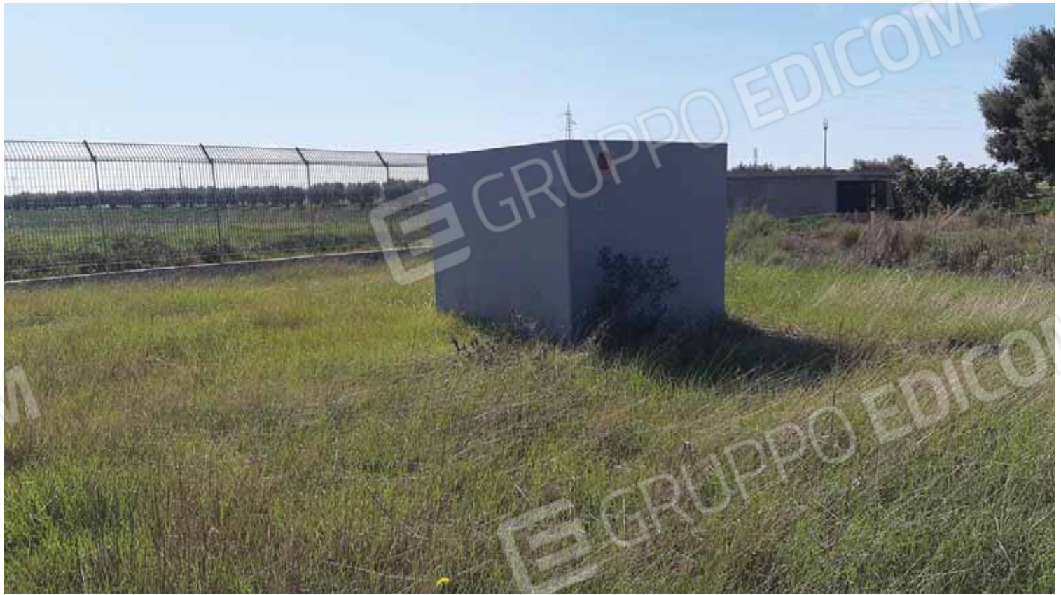
Foto terreno, Foglio 123, part. 45/59/100, impianti tecnologici
