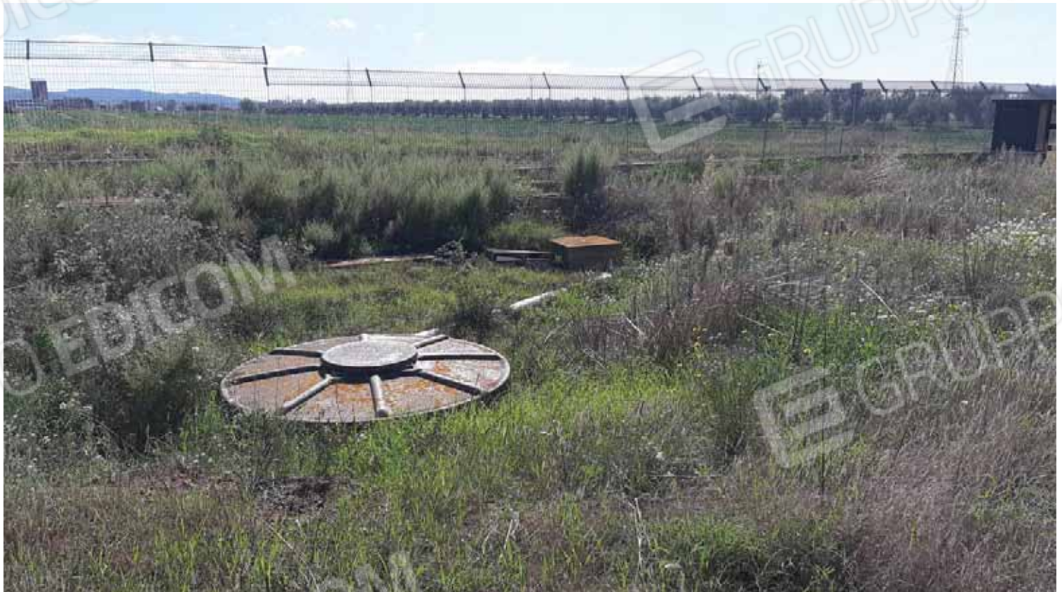
Foto terreno, Foglio 123, part. 45/59/100, impianti tecnologici.
