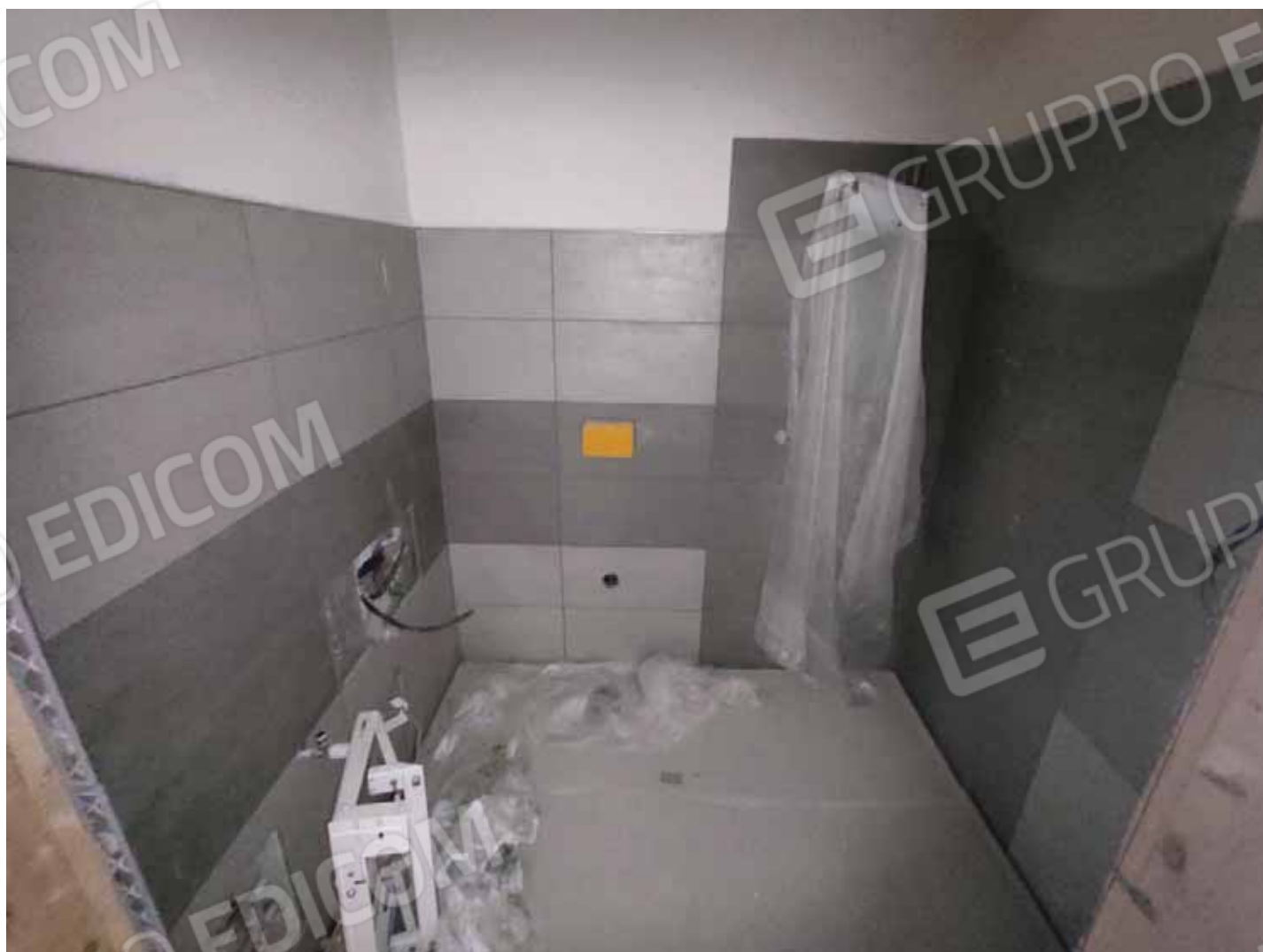
Impianto di riscaldamento /raffrescamento
