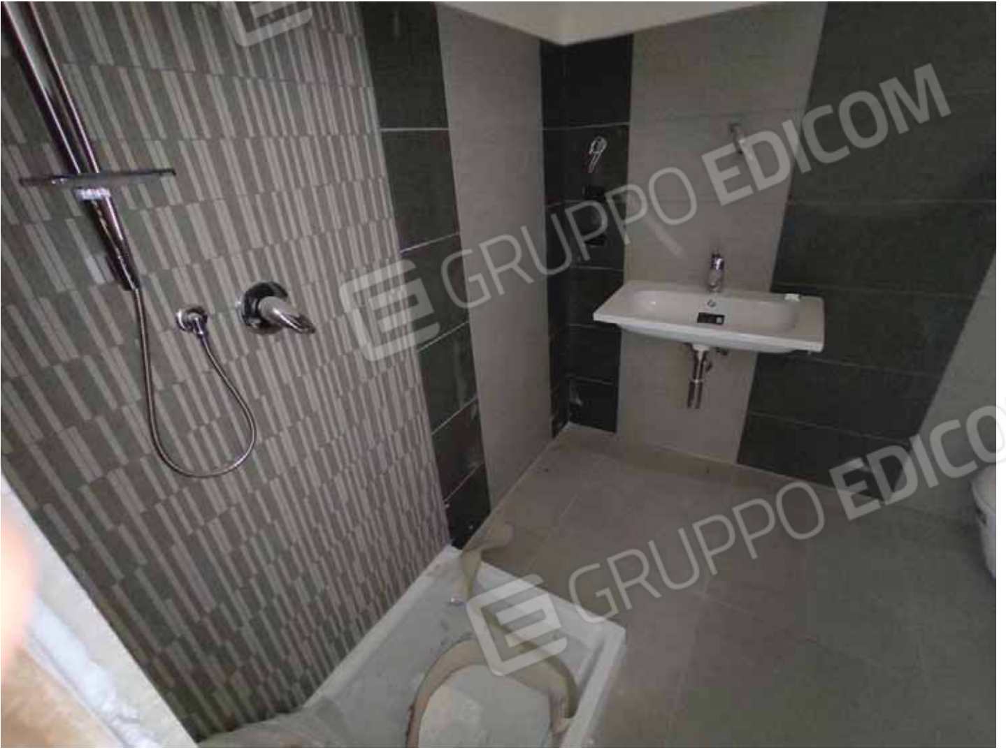
Tipologia di bagno al piano secondo
