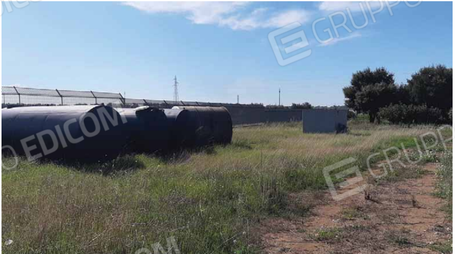
Foto terreno Foglio 123, part.45/59/100 , impianti tecnologici
