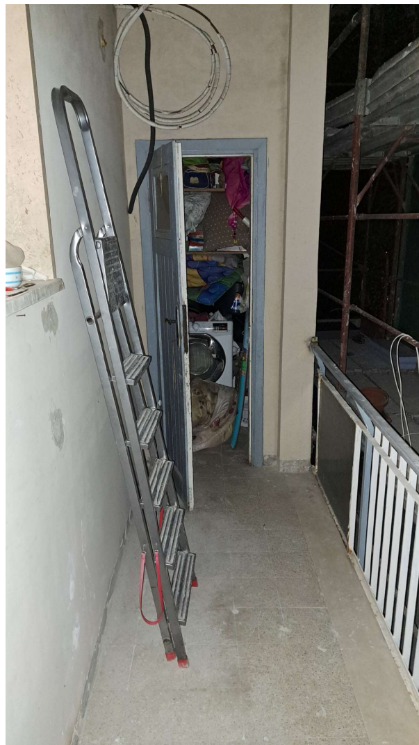
BALCONE LATO CUCINA
