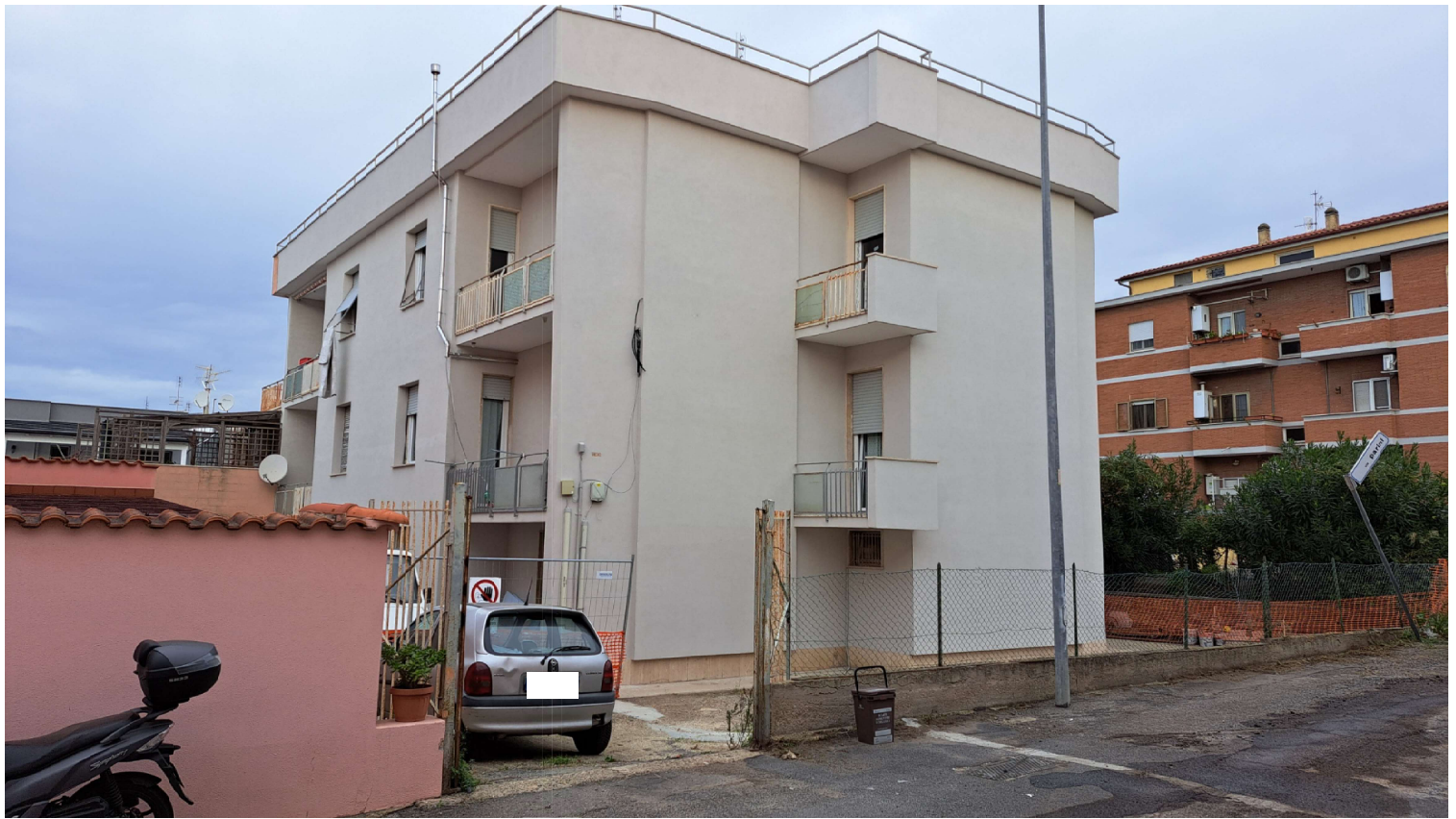
FOTO VISTA DA VIA G PARINI
