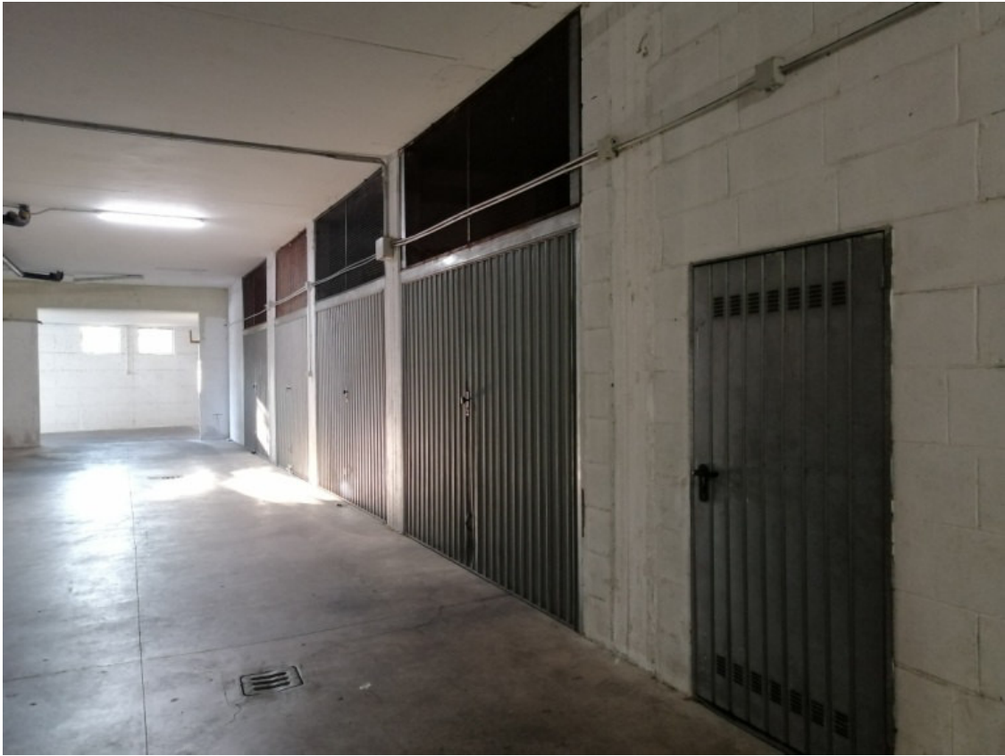
BOX - AUTO E RPOSTIGLIO AL PIANO SEMINTERRATO
