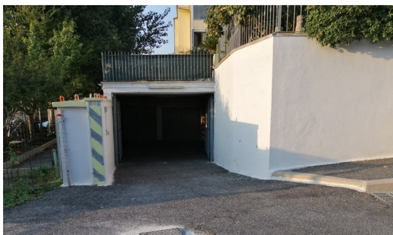
INGRESSO AL PIANO SEMINTERRATO
