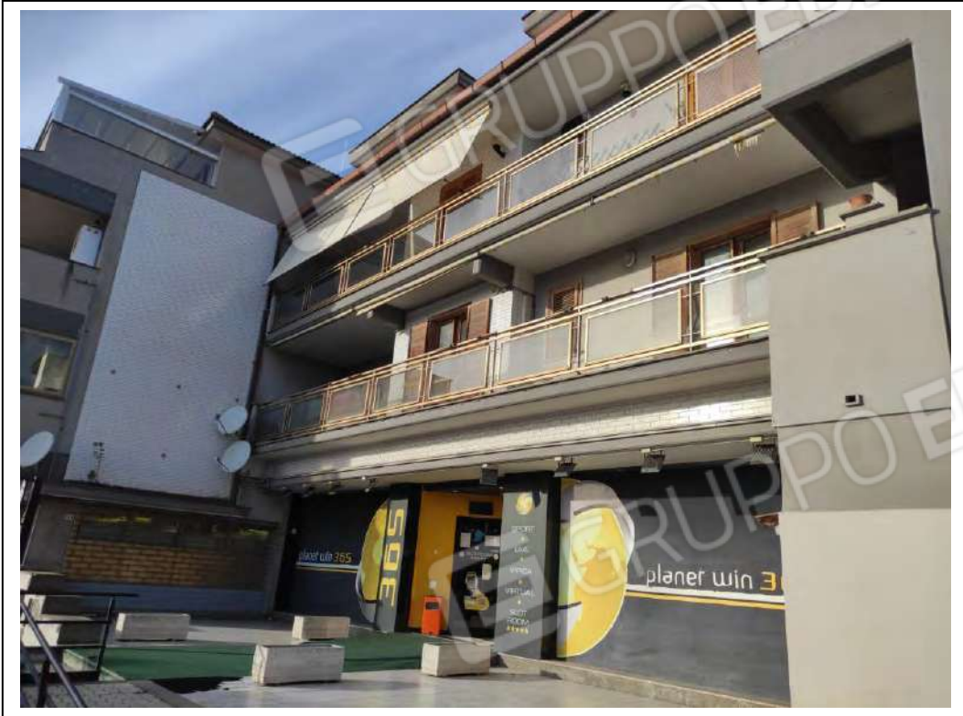
FOTO 3 – Prospetto frontale – Via Taranto
