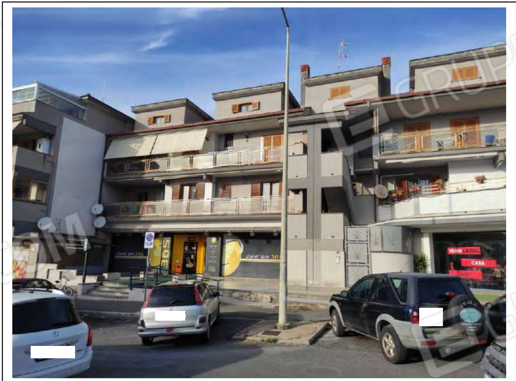
FOTO 2 - Prospetto frontale – Via Taranto
