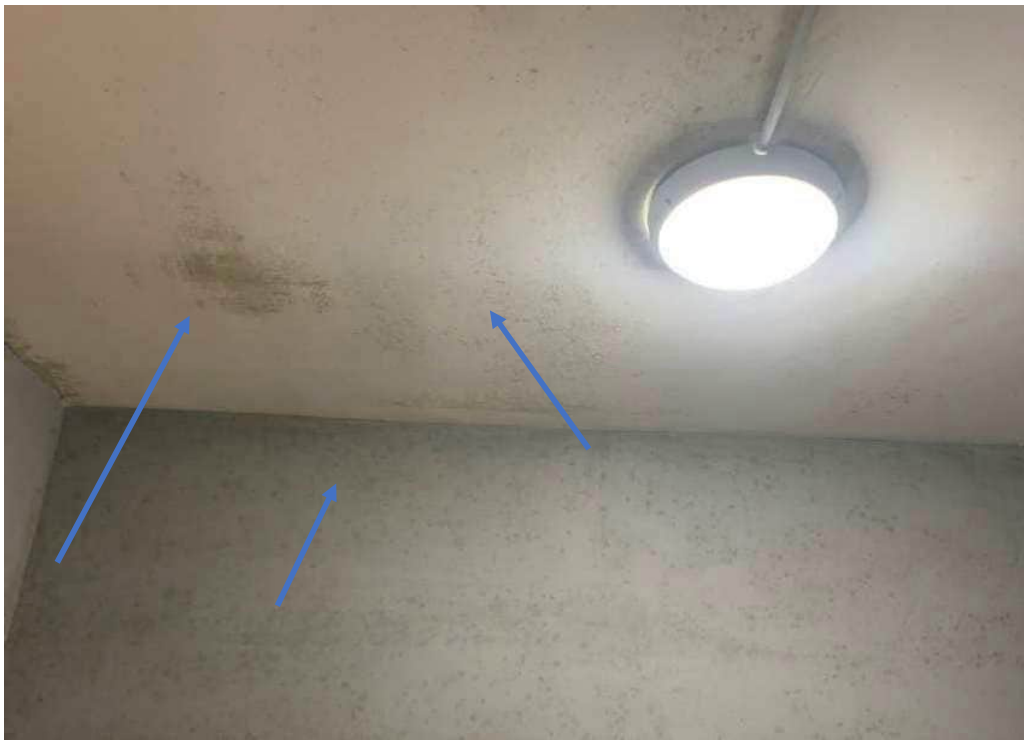
Infiltrazioni sul controsoffitto dell'antibagno in cartongesso
