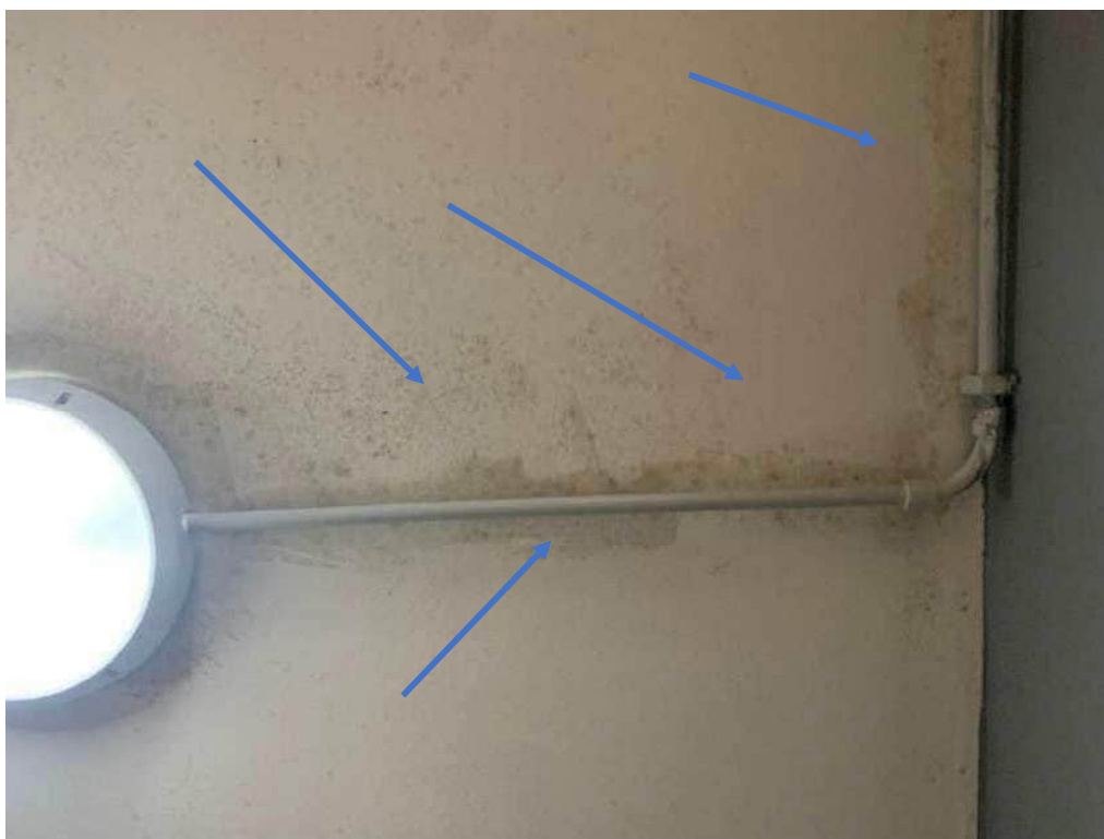
Presenza di infiltrazioni lungo l'impianto elettrico a vista
