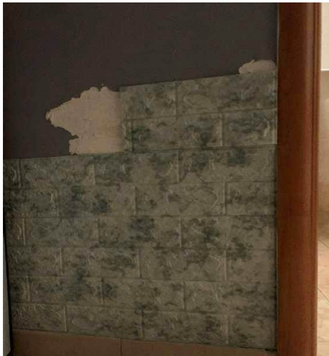
Fenomeni di distacco intonaco parete bagno
