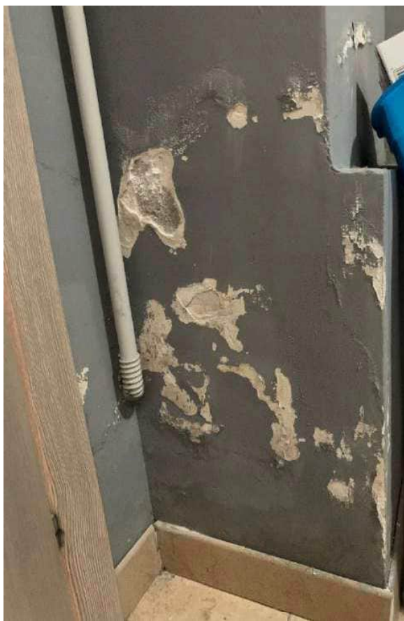
Fenomeni di umidità' parete cartongesso antibagno
