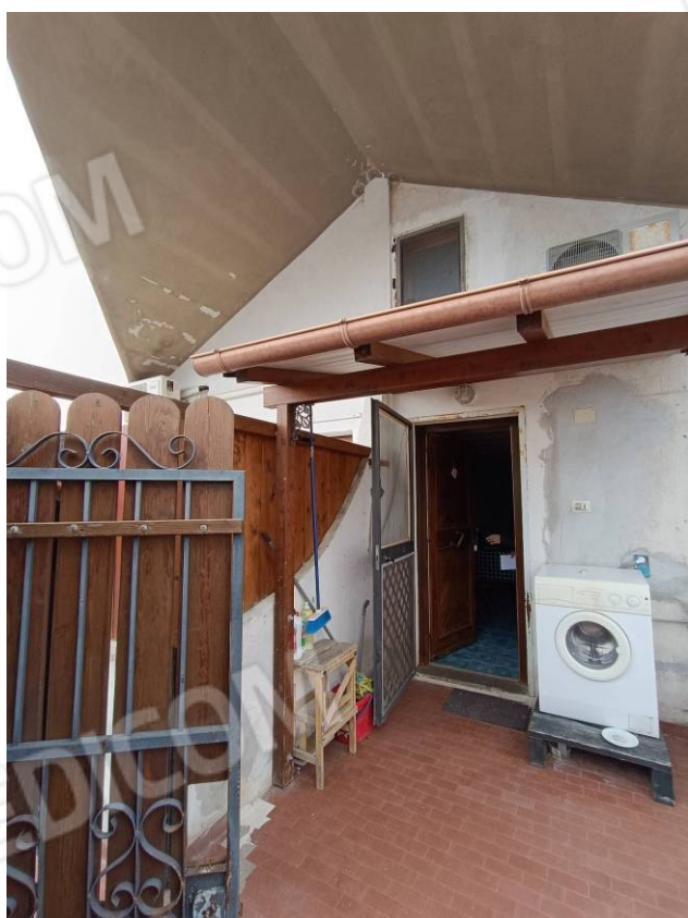
Figg. 12-15 Terrazza pertinenziale esclusiva dell'unità immobiliare in esame: sono presenti n. 2 tettoie di \approx 3,00\text{mq/cad} , di cui una occupata da armadiatura in alluminio impiegata quale ripostiglio; in alto si intravede la finestra che dà luce al soppalco interno. Tettoie, finestra e soppalco interno sono tutti realizzati senza previo titolo.
