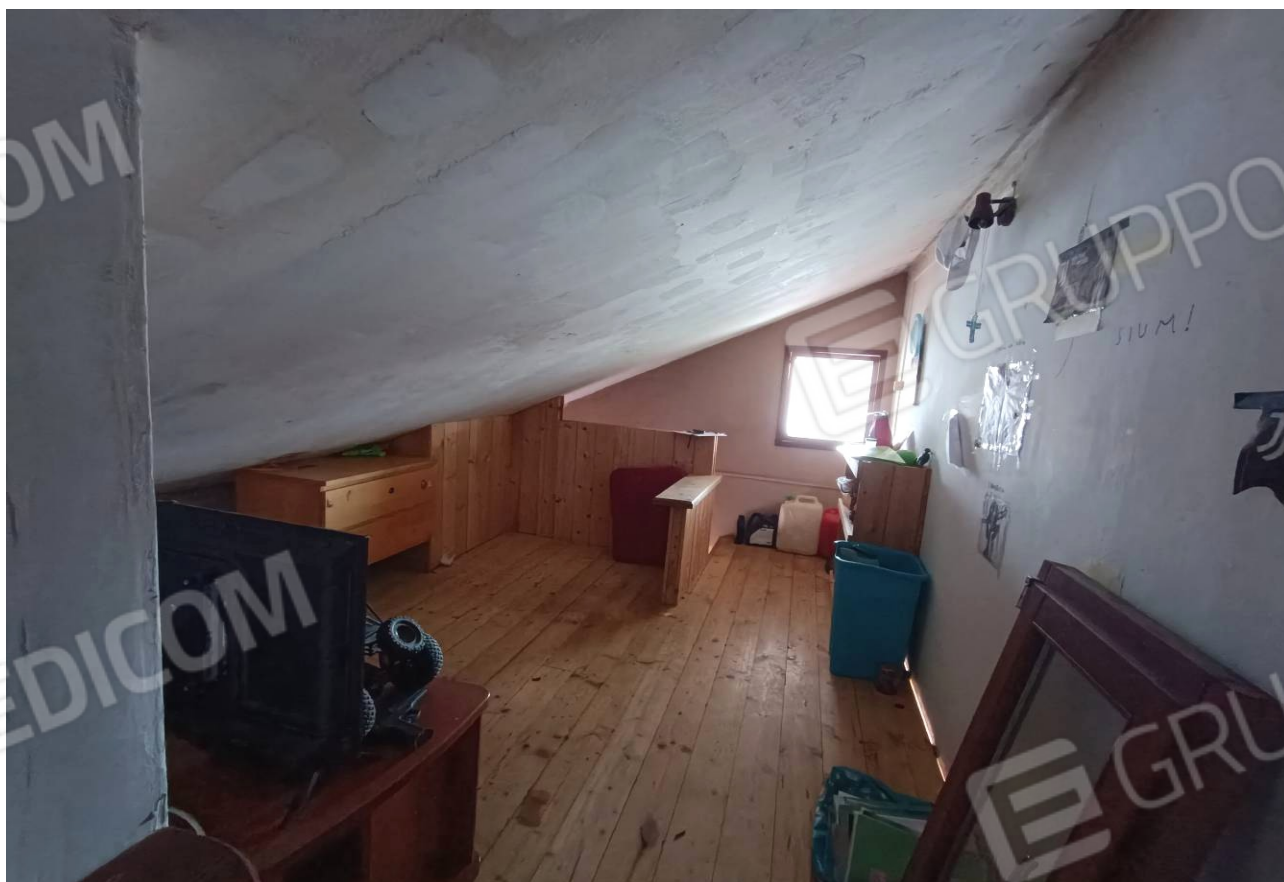
Figg. 36-37 Interno: Soppalco in legno non abitabile (Hm \approx 1,40m) realizzato senza previo titolo sulla superficie del soggiorno/pranzo/a.c.; da progetto originario infatti l'unità immobiliare presenta copertura inclinata a tutta altezza nei 3 vani (soggiorno/bagno/camera), dal che è stato realizzato il soppalco per sfruttare l'altezza in virtù di maggior superficie utile (benché appunto non abitabile); la struttura dovrà essere rimossa
