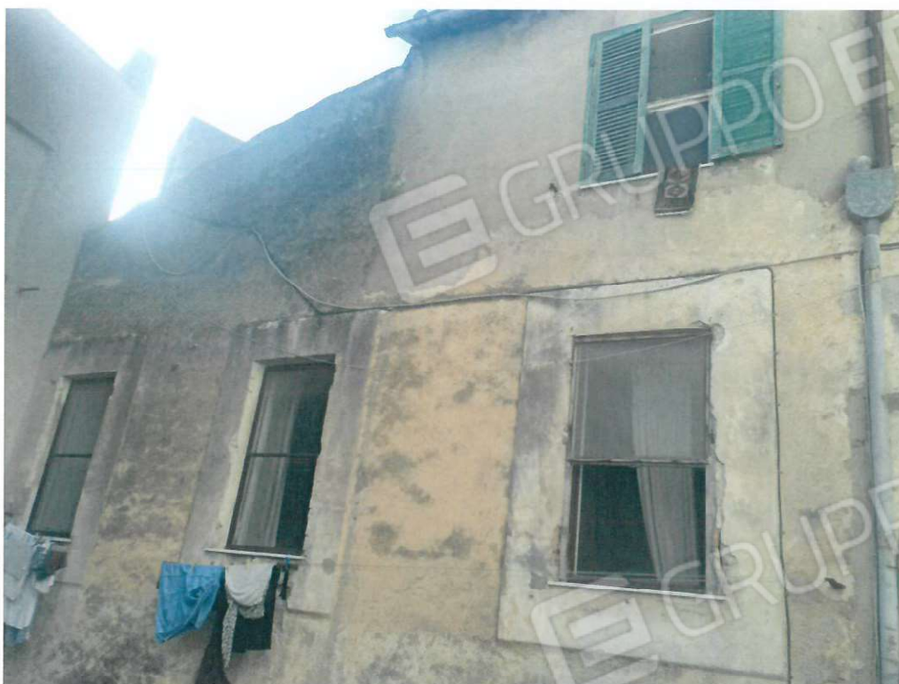
Foto 12 – Foto esterna su chiostrina
