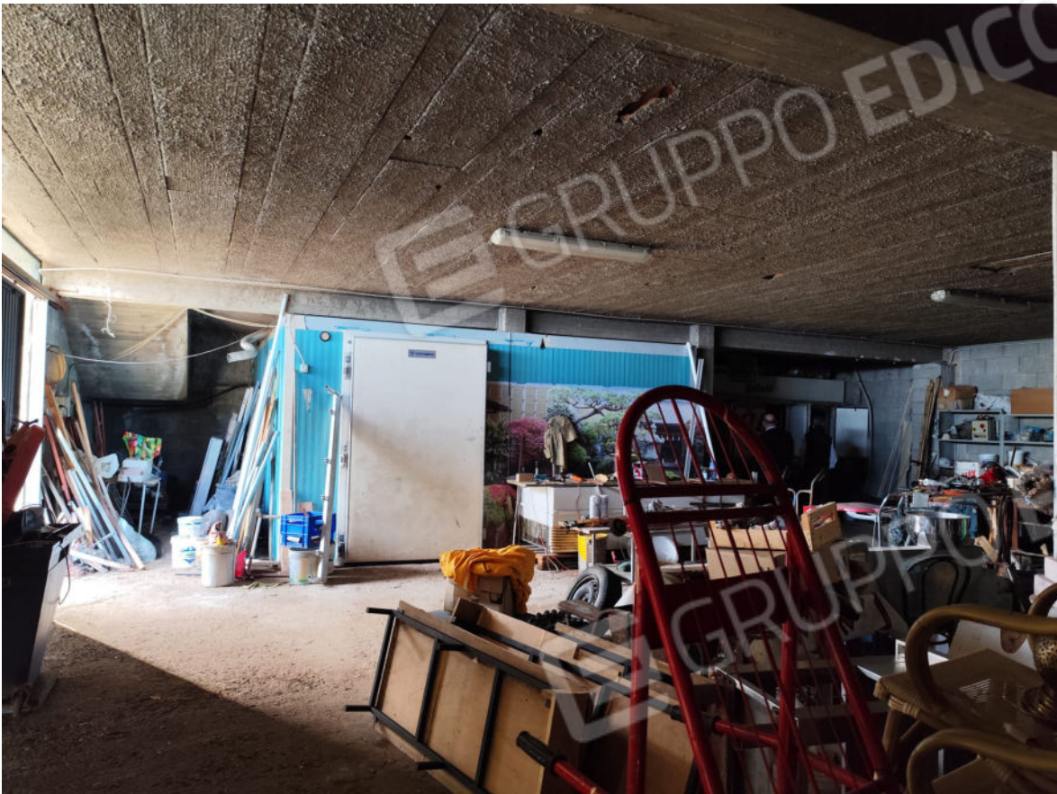
Foto 11 interno autorimessa sub 33 con cella frigo
