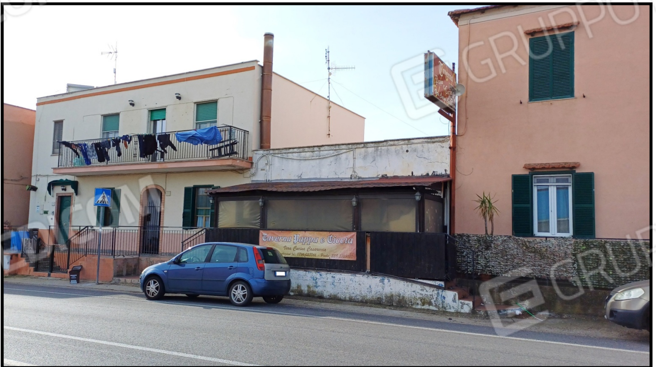
Foto 2: La facciata principale con l'illegittima veranda antistante l'ingresso del locale.
