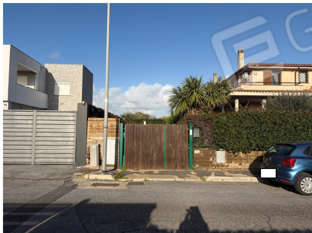
Edificio via Stoccolma n. 16B
