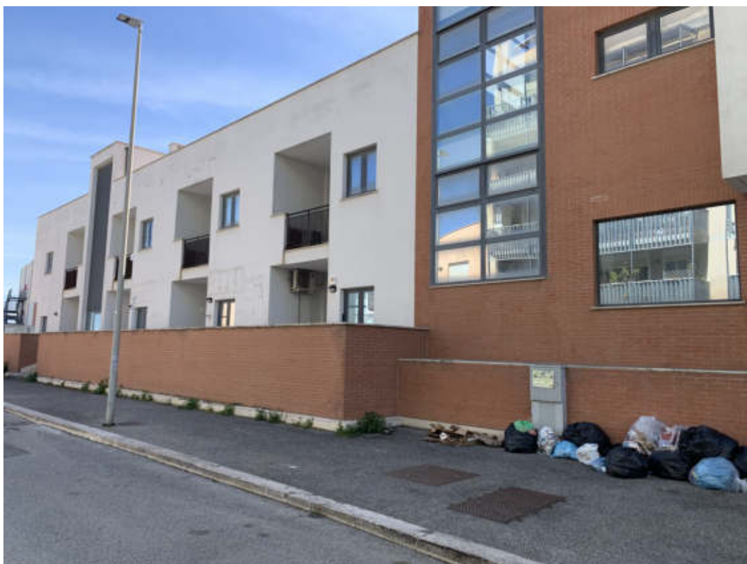
Foto N. 1: Particolare della palazzina condominiale da Via Enrico Berlinguer verso il lato finestrato dell'ufficio;
