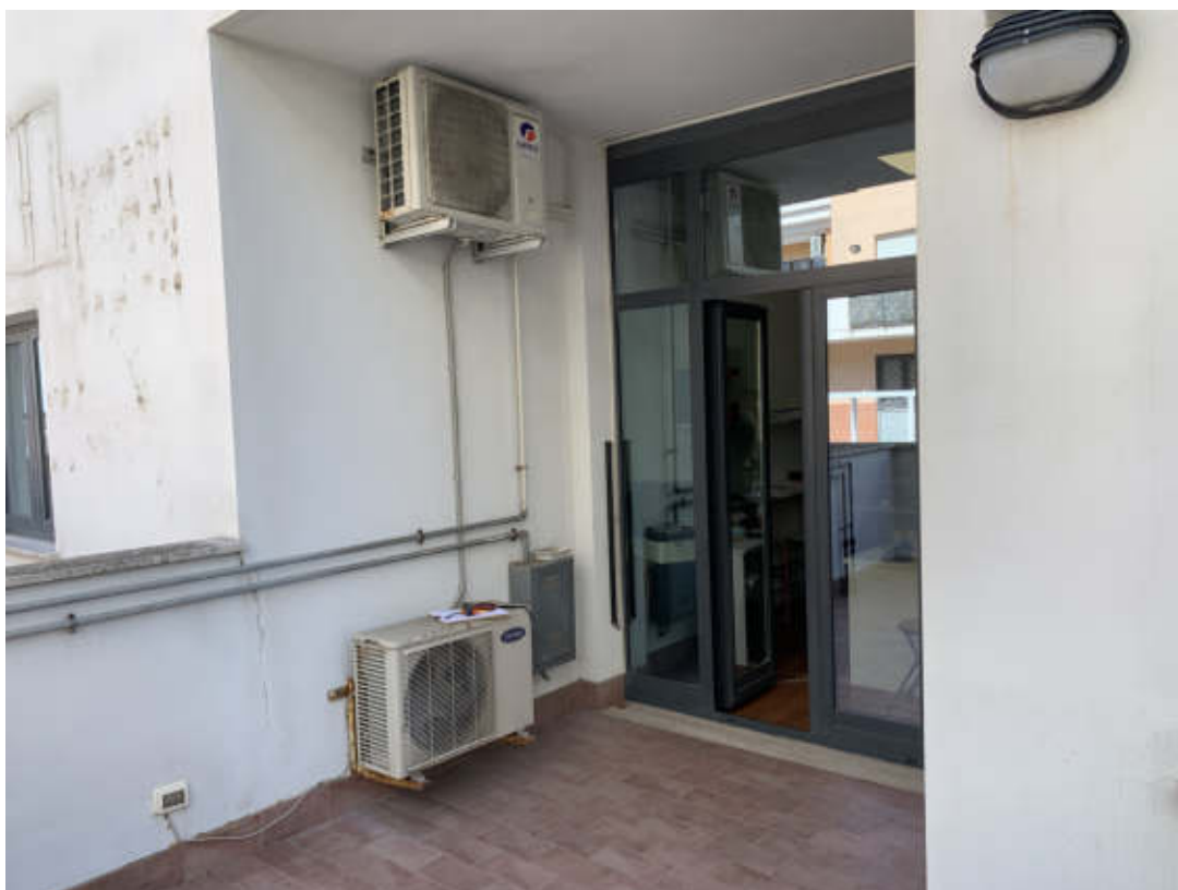
Foto N. 5: Particolare del balcone accessorio dell'ufficio
