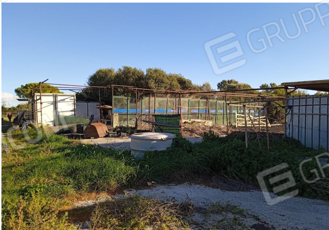
Foto n. 8 – Accesso alle part.lle 776 e 777 da via di Torre Valdalica
