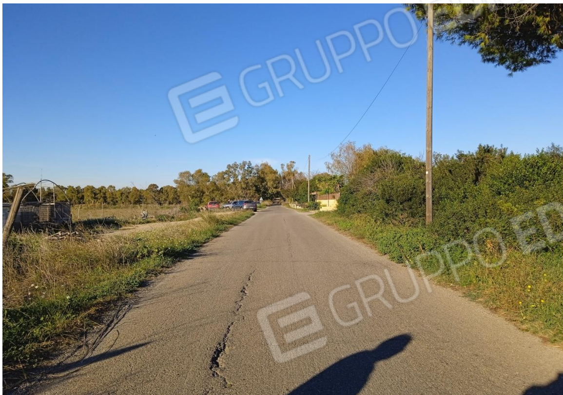
Foto n.1 — via di Torre Valdalica – a sinistra il terreno
