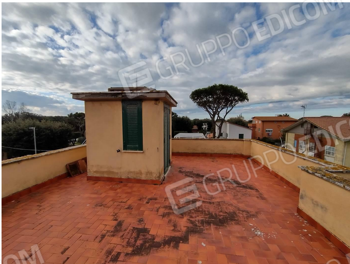
Vista della terrazza di copertura
