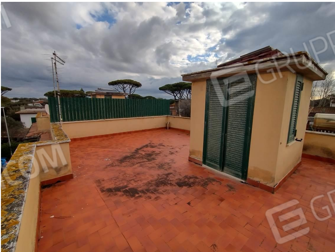
Vista della terrazza di copertura
