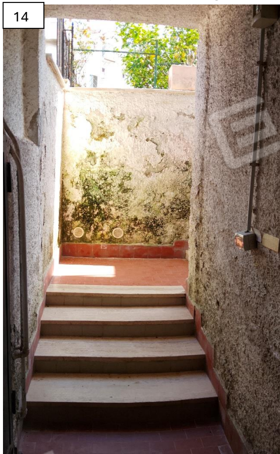
Foto 14_ Scala e percorso di collegamento con il piano seminterrato e le cantine condominiali
