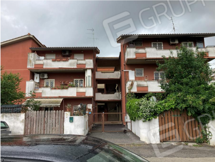
1 – Prospetto su via Fratelli Ferretti vista cancello ingresso al fabbricato n. civico 17
