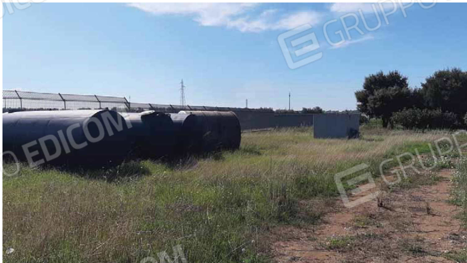
Foto terrreno Foglio 123, part.45/59/100 , impianti tecnologici
