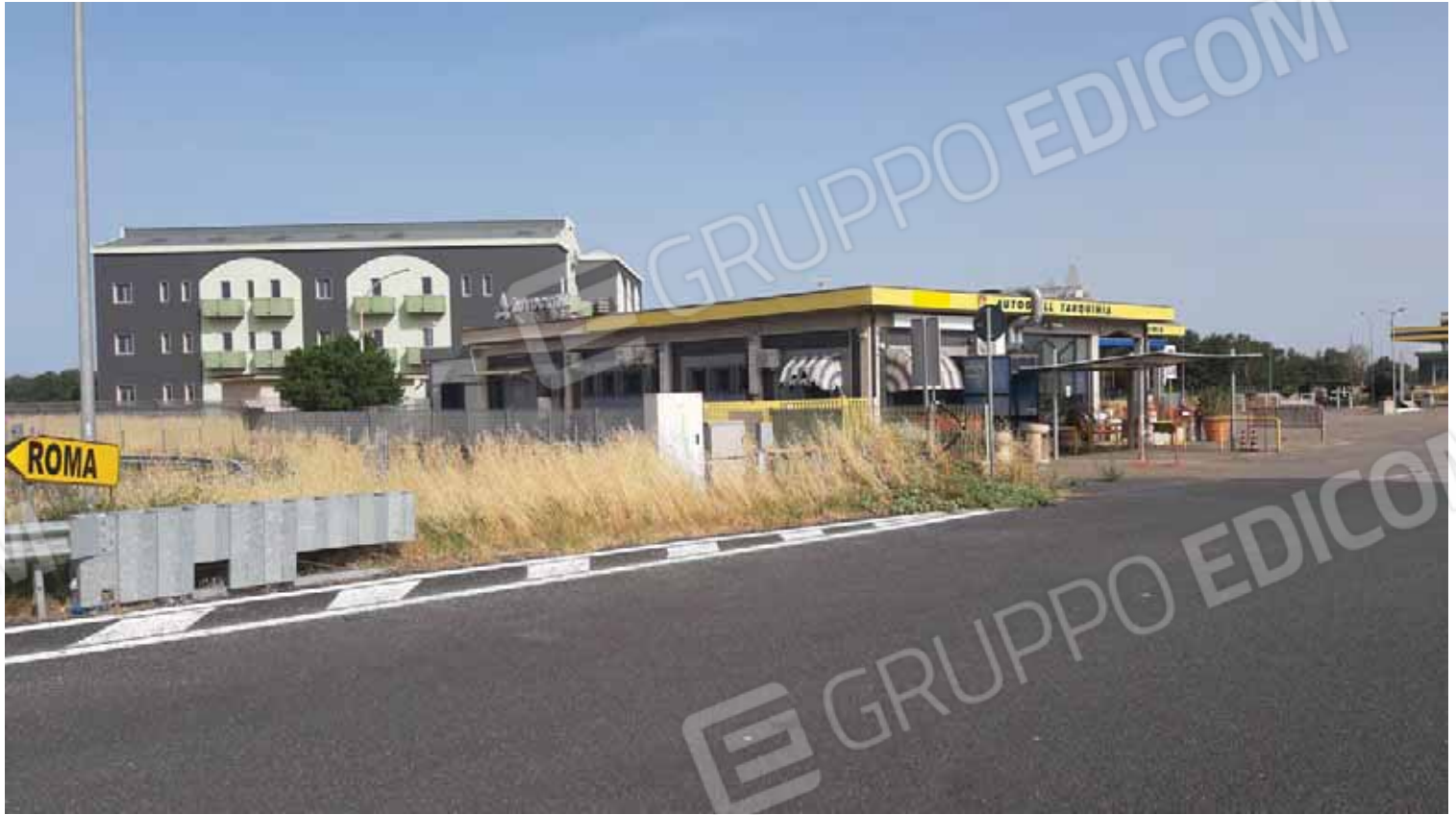
Struttura ricettiva lato autogrill
