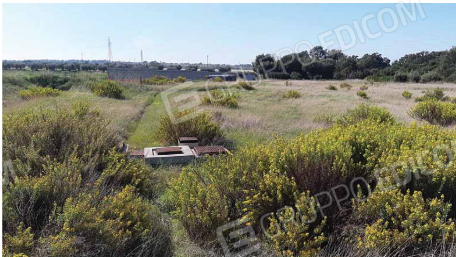
Foto terreno Foglio 123, part. 45/59/100, impinti tecnologici.
