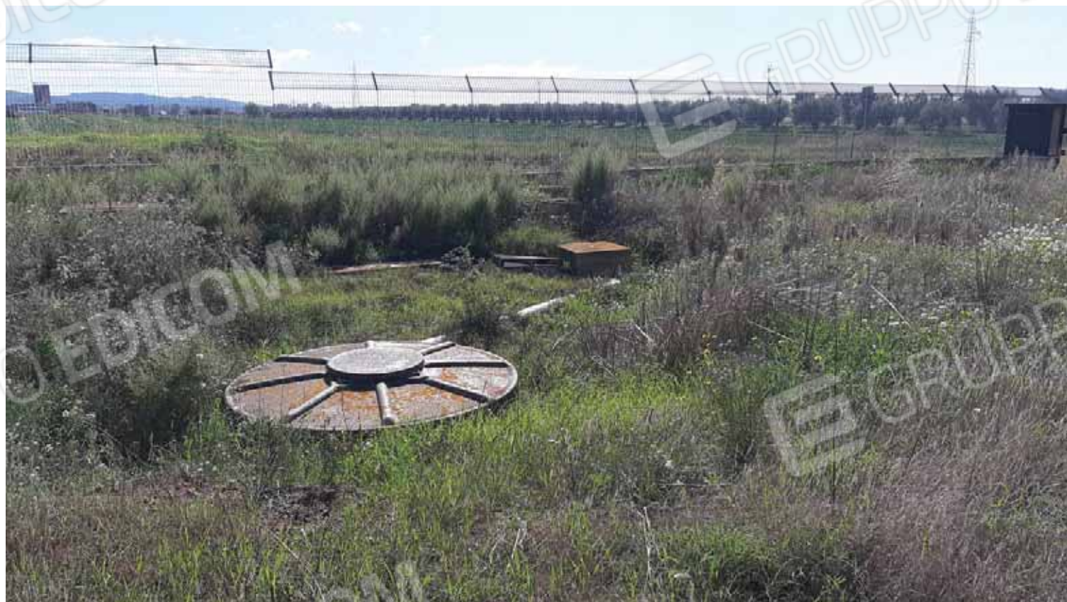
Foto terreno, Foglio 123, part. 45/59/100, impianti tecnologici.
