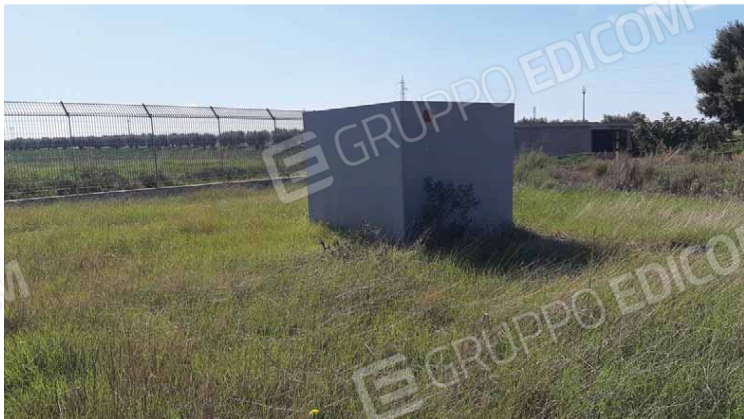
Foto terreno, Foglio 123, part. 45/59/100, impianti tecnologici
