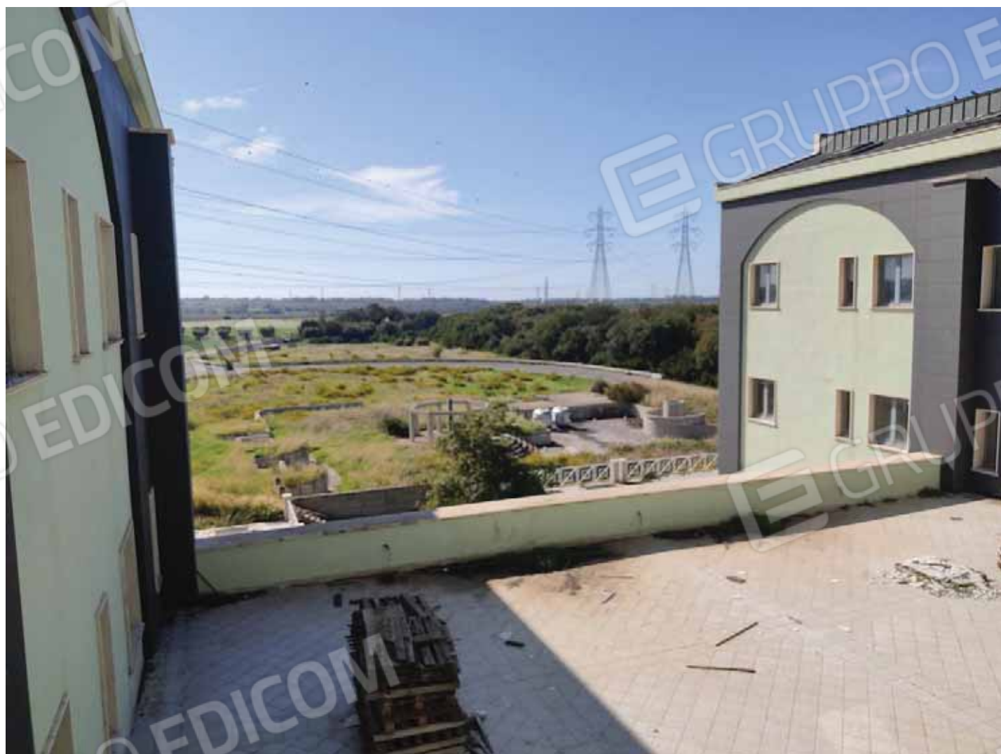
Vista terrazzo da balcone al primo piano
