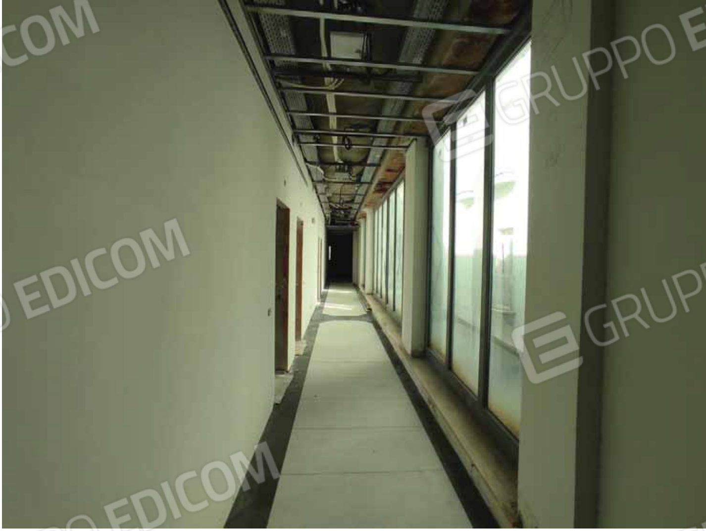
Corridoio piano terra
