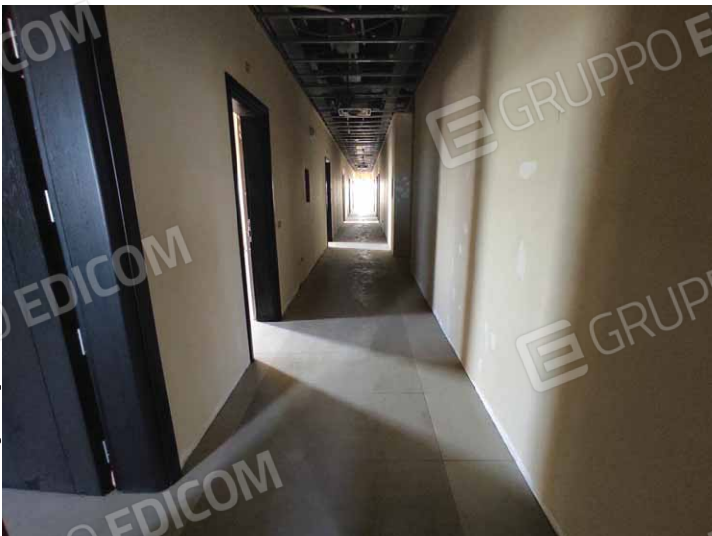
Corridoio piano primo
