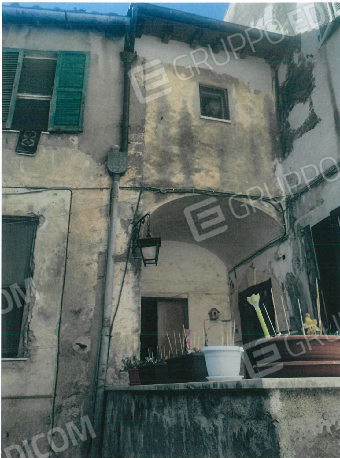
Foto 11 – Foto esterna su chiostrina
