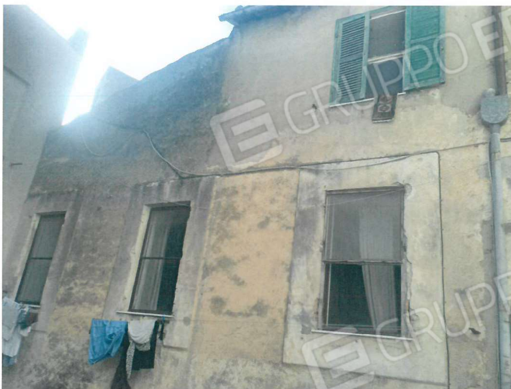
Foto 12 – Foto esterna su chiostrina
