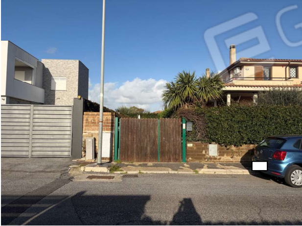
Edificio via Stoccolma n. 16B
