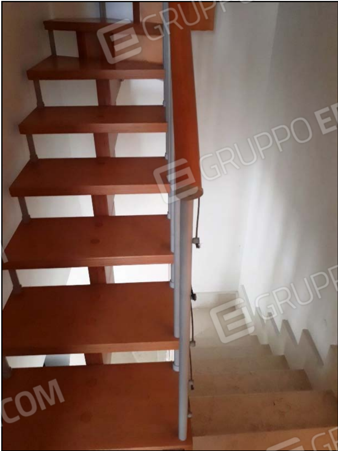
Scala di accesso soffitta
