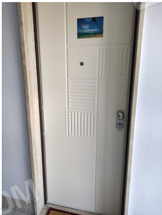
Foto 3: portoncino di ingresso
