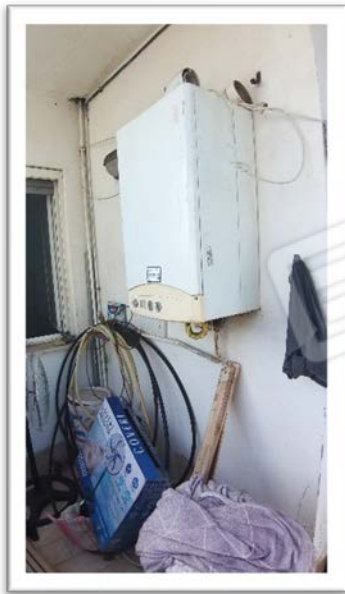
Foto 31 – Balcone ad angolo
