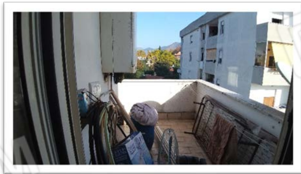
Foto 27 – Balcone ad angolo
