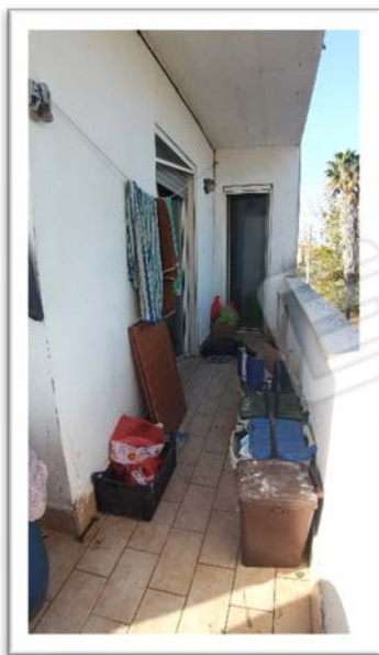
Foto 29 – Balcone ad angolo
