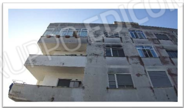
Foto 32 -Vista esterna lato ingresso condominiale
