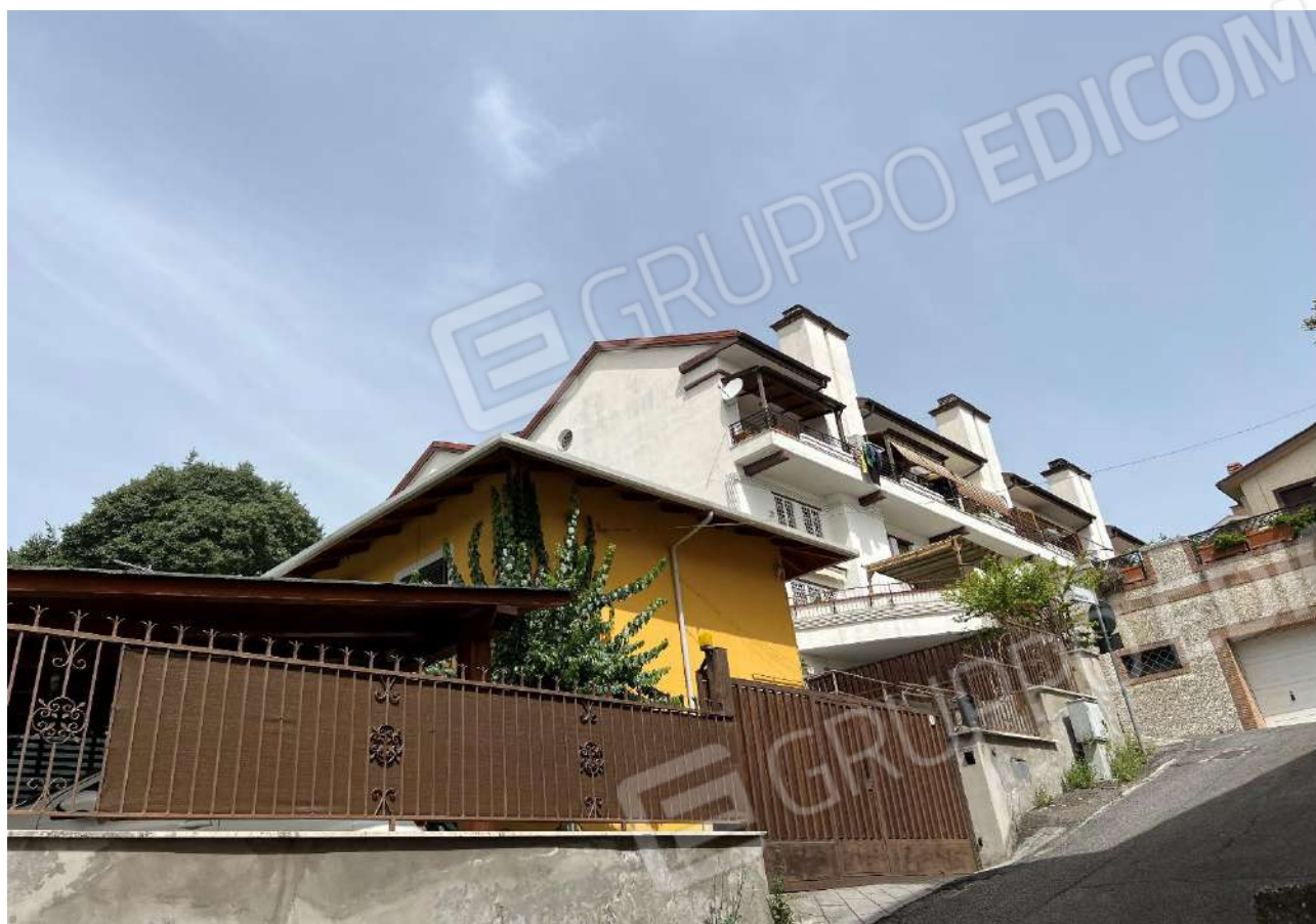
FOTO 3: Veduta esterna prospetto sud-est abitazione
