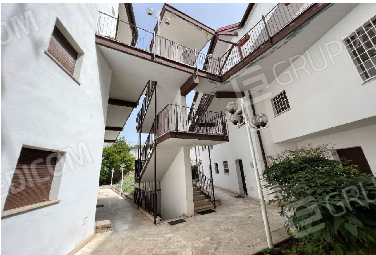
FOTO 4: Veduta vano scala condominiale e cortile a piano terra
