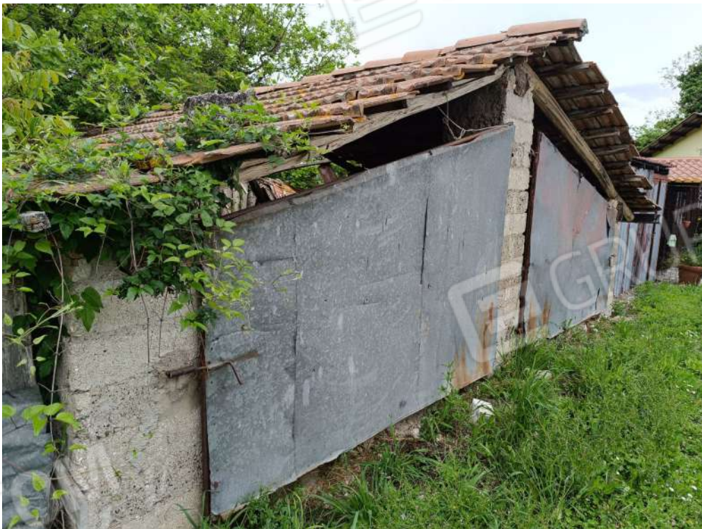
Foto n. 19 - Foglio 133 p.lla 566 - Rimessa
