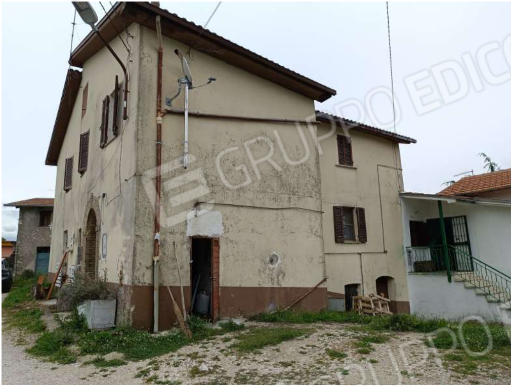
Foto n. 2 – Prospetto sud del fabbricato
