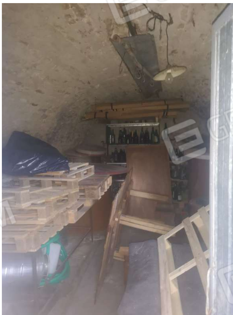
Foto n. 13 - Cantina al piano seminterrato
