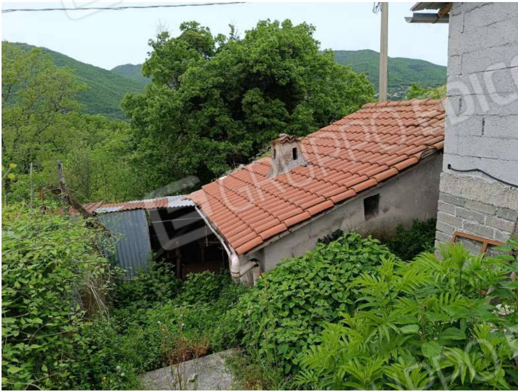
Foto n. 18 - Foglio 133 p.lla 536 - Magazzino
