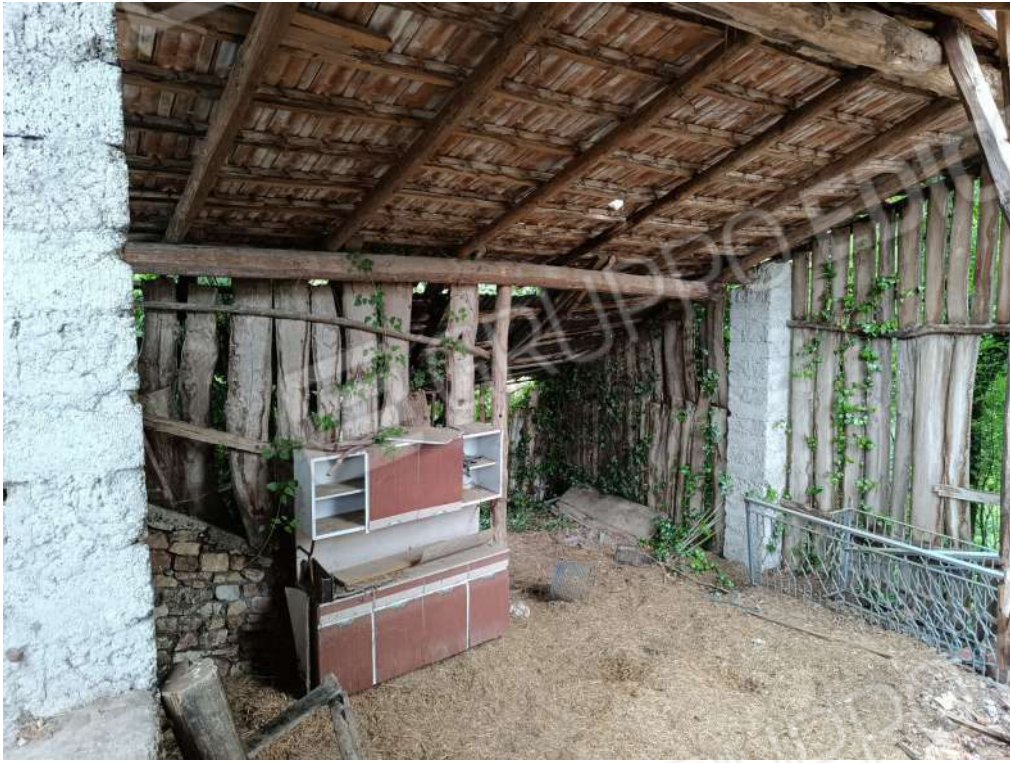
Foto n. 7 - Foglio 133 p.lla 566 - Rimessa
