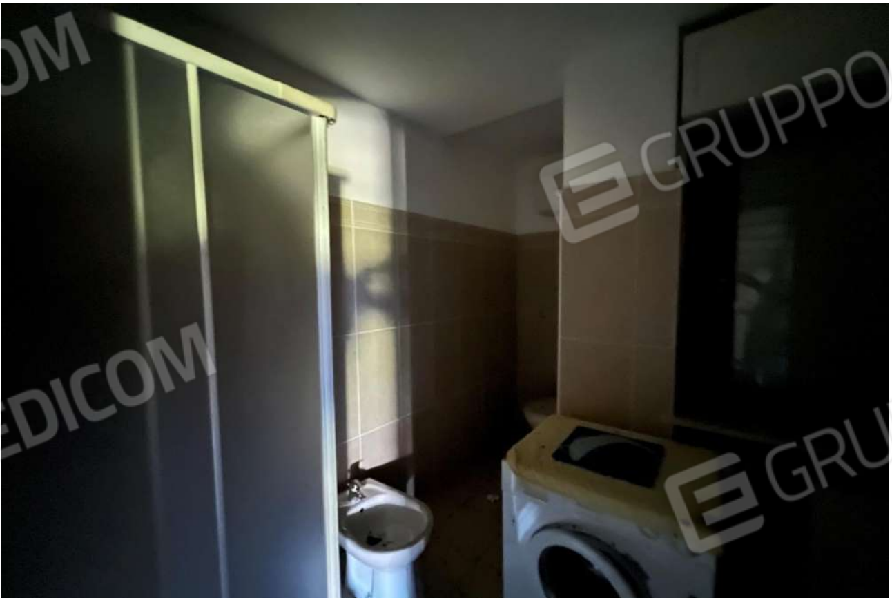
FOTO 18: Veduta interna vano bagno Lotto 2, Corpo A-piano terra
