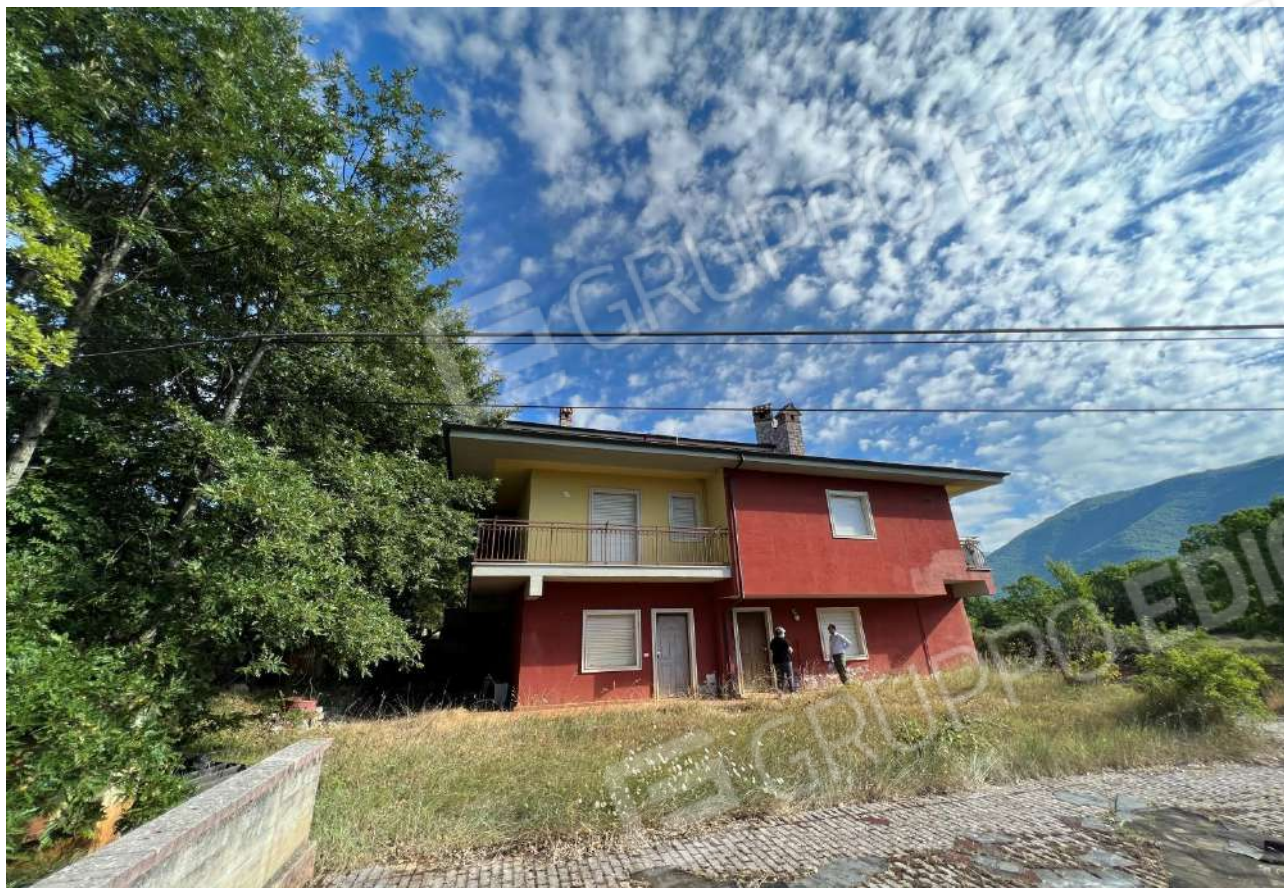
FOTO 3: Veduta esterna lato sud-ovest
