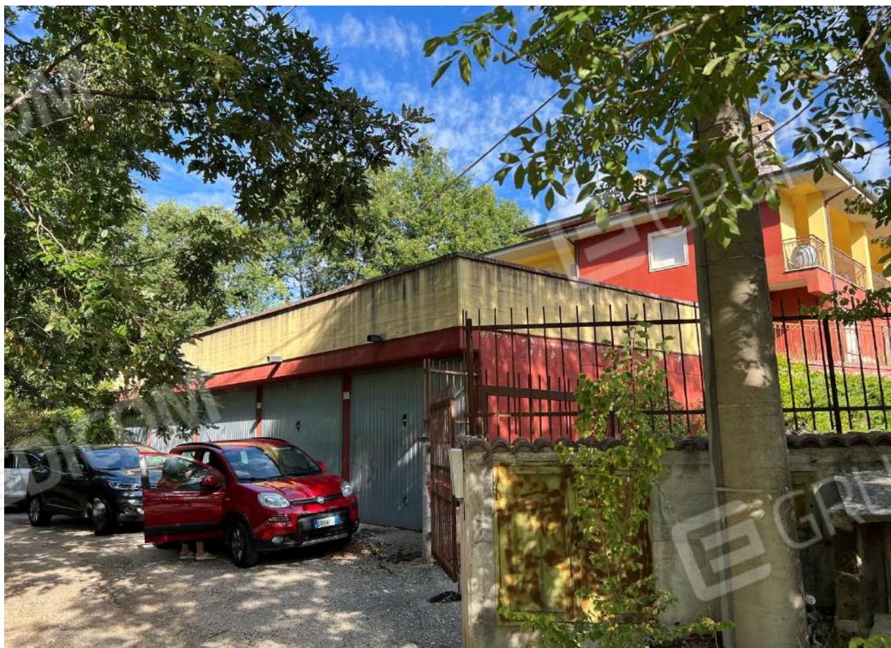
FOTO 6: Veduta esterna garage interrati su via Defensa
