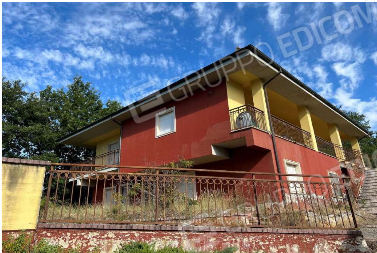
FOTO 1: Veduta esterna lato sud-est
