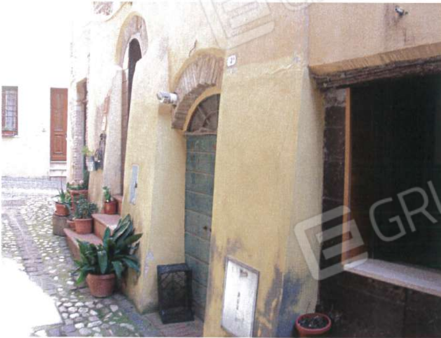
Vedute esterne del fabbricato
