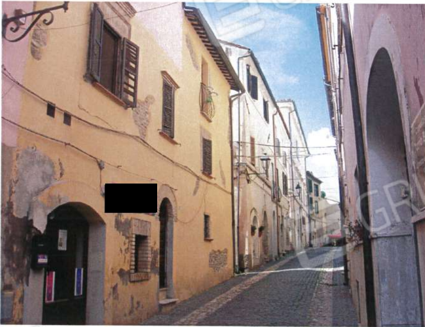
Vedute esterne del fabbricato da corso Umberto I
