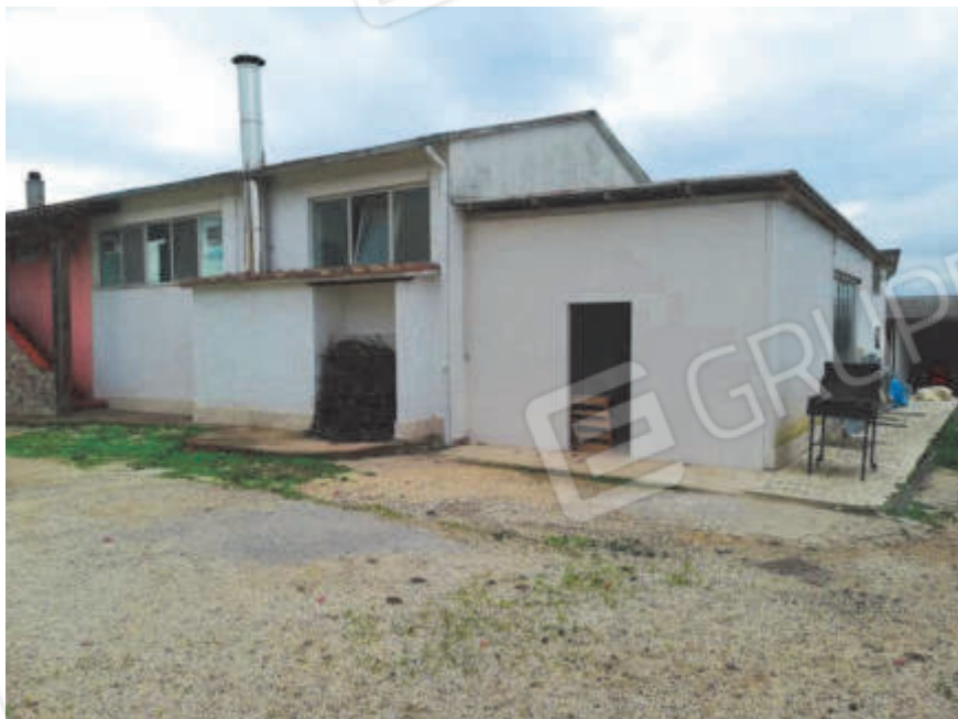
Foto 3 – Vista esterna – Prospetto sud
