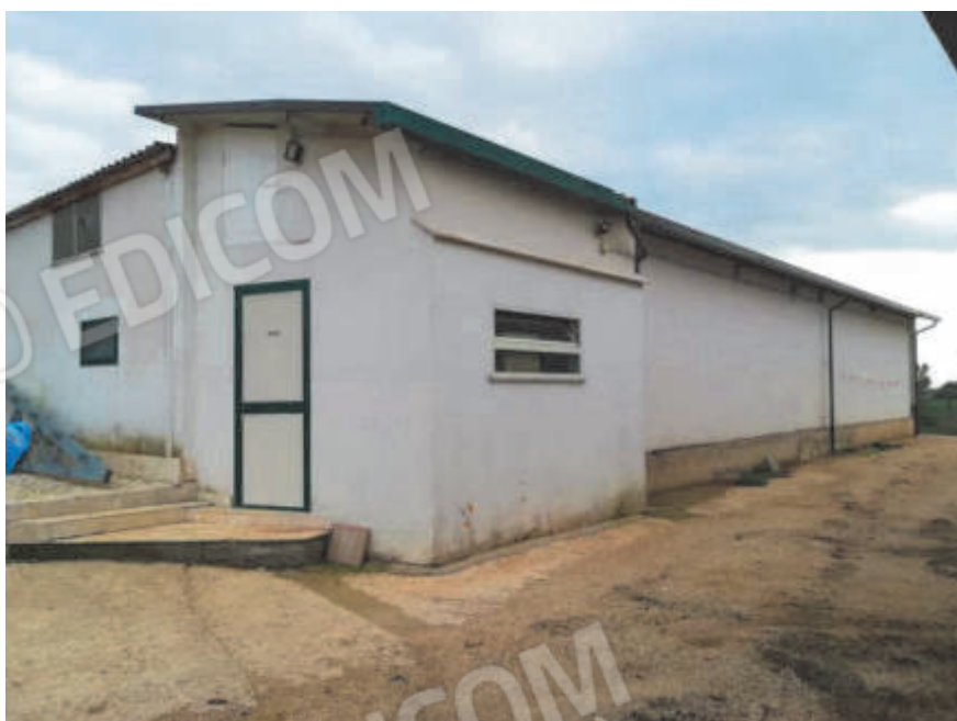
Foto 5 – Vista esterna – Prospetto nord
