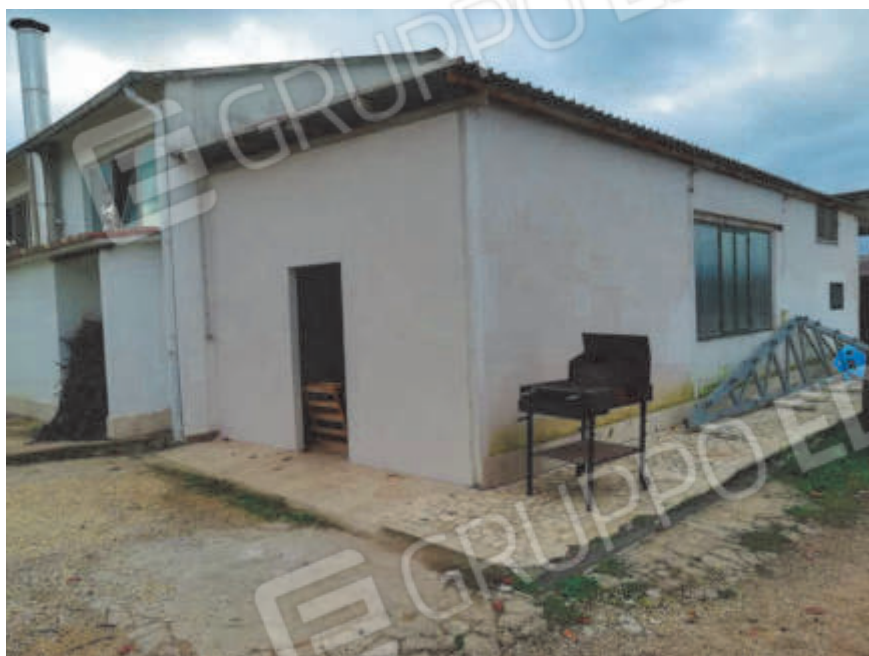
Foto 4 – Vista esterna – Prospetto sud/est
