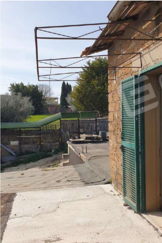
FOTO 13: Veduta esterna balcone piano T sub. 2
