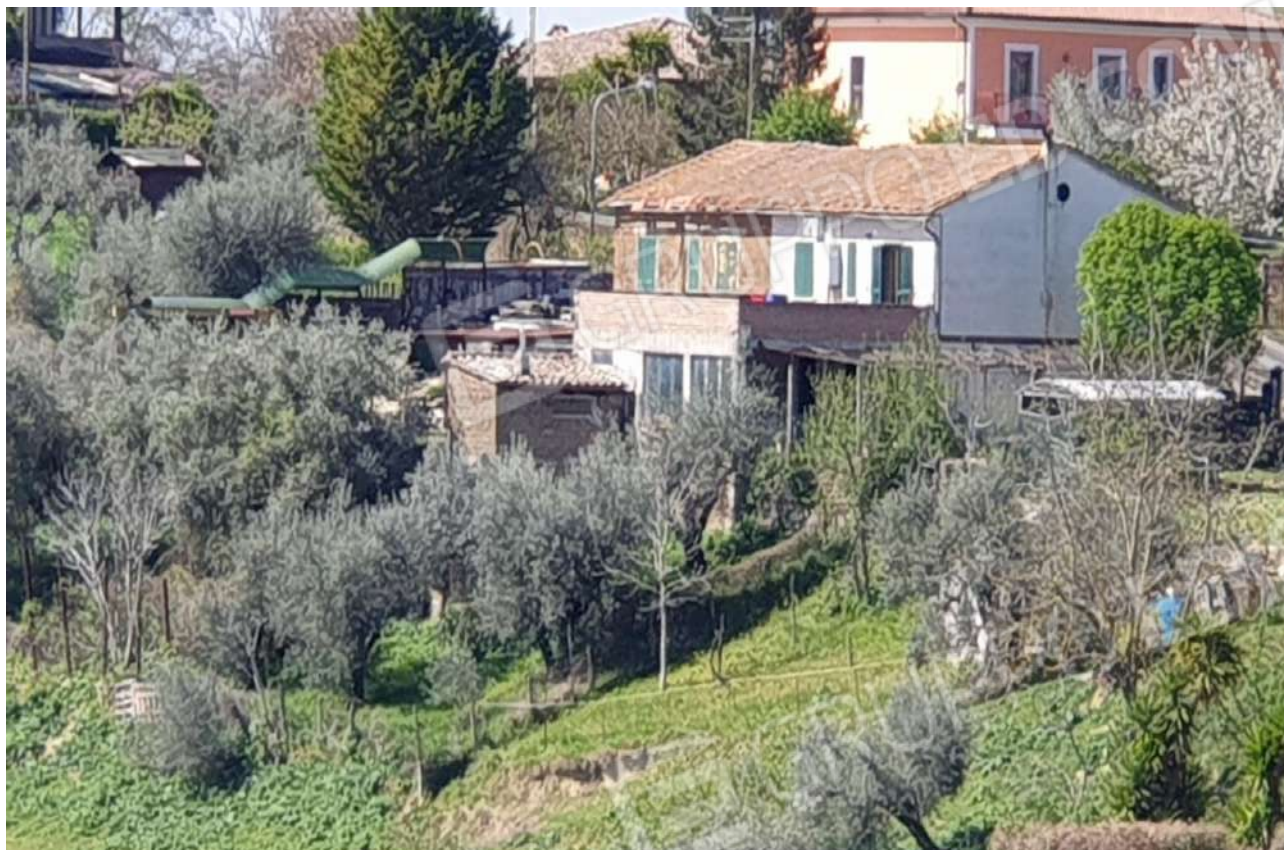
FOTO 18: Veduta esterna prospettica terreni partt. 202 e 248
