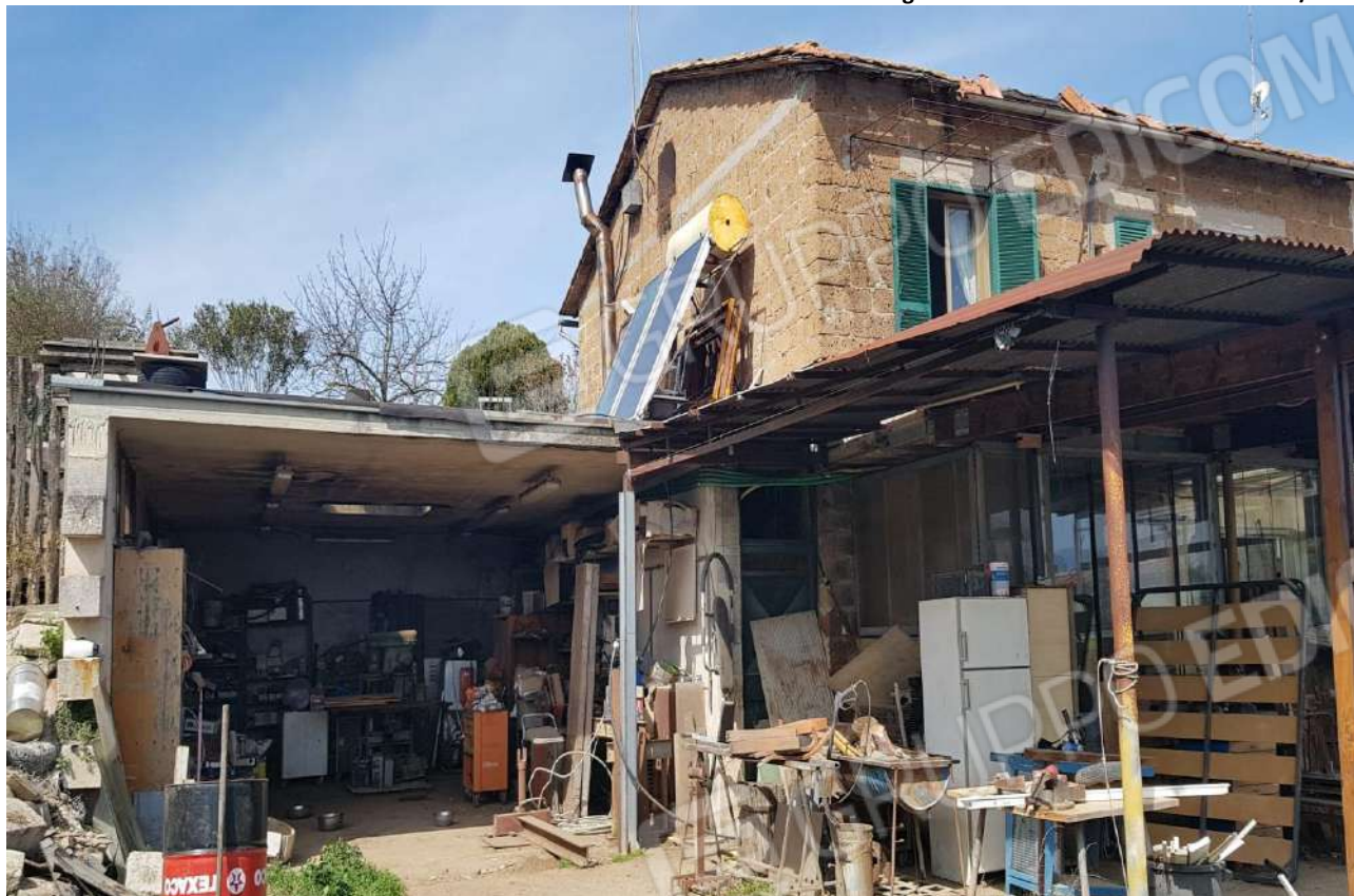
FOTO 5: Veduta esterna prospetto posteriore da part. 202
