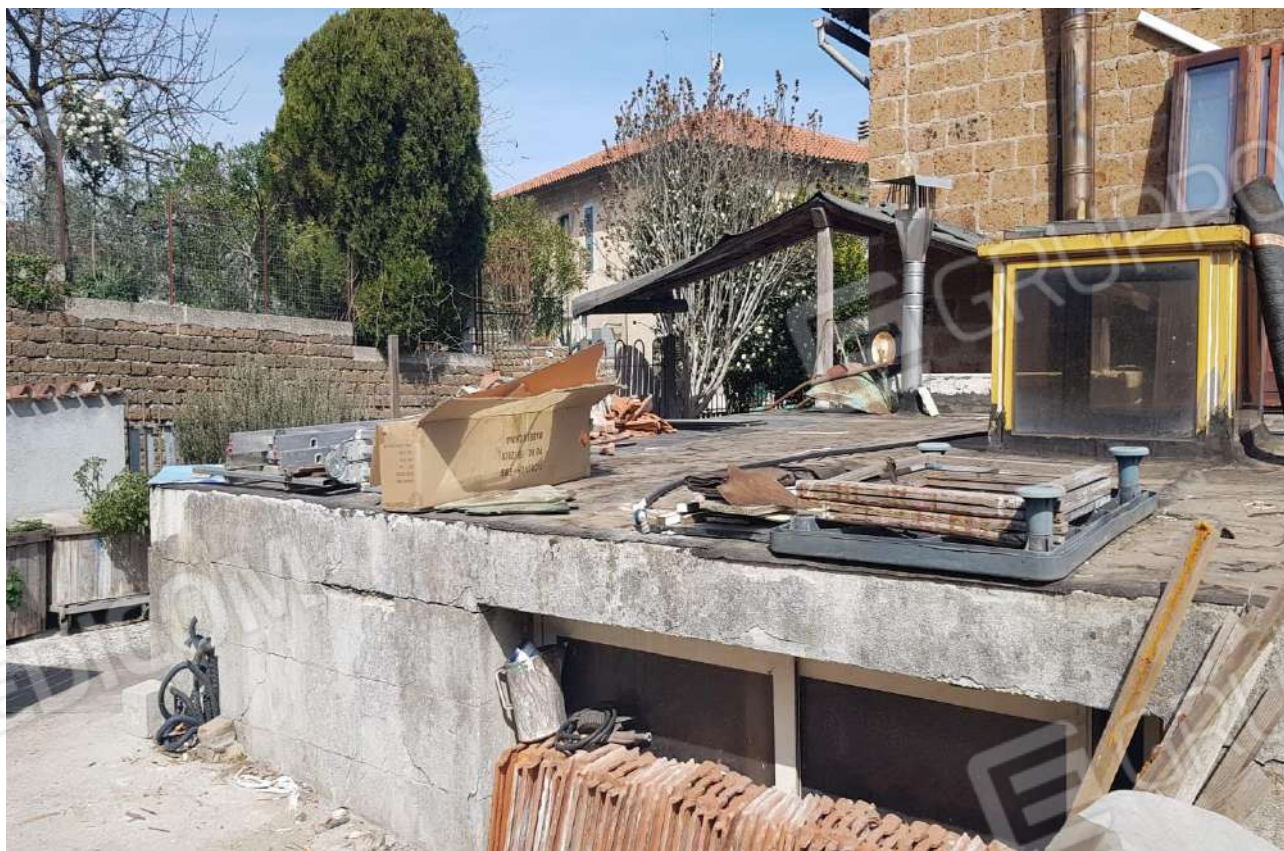
FOTO 4: Veduta esterna prospetto laterale da part. 248
