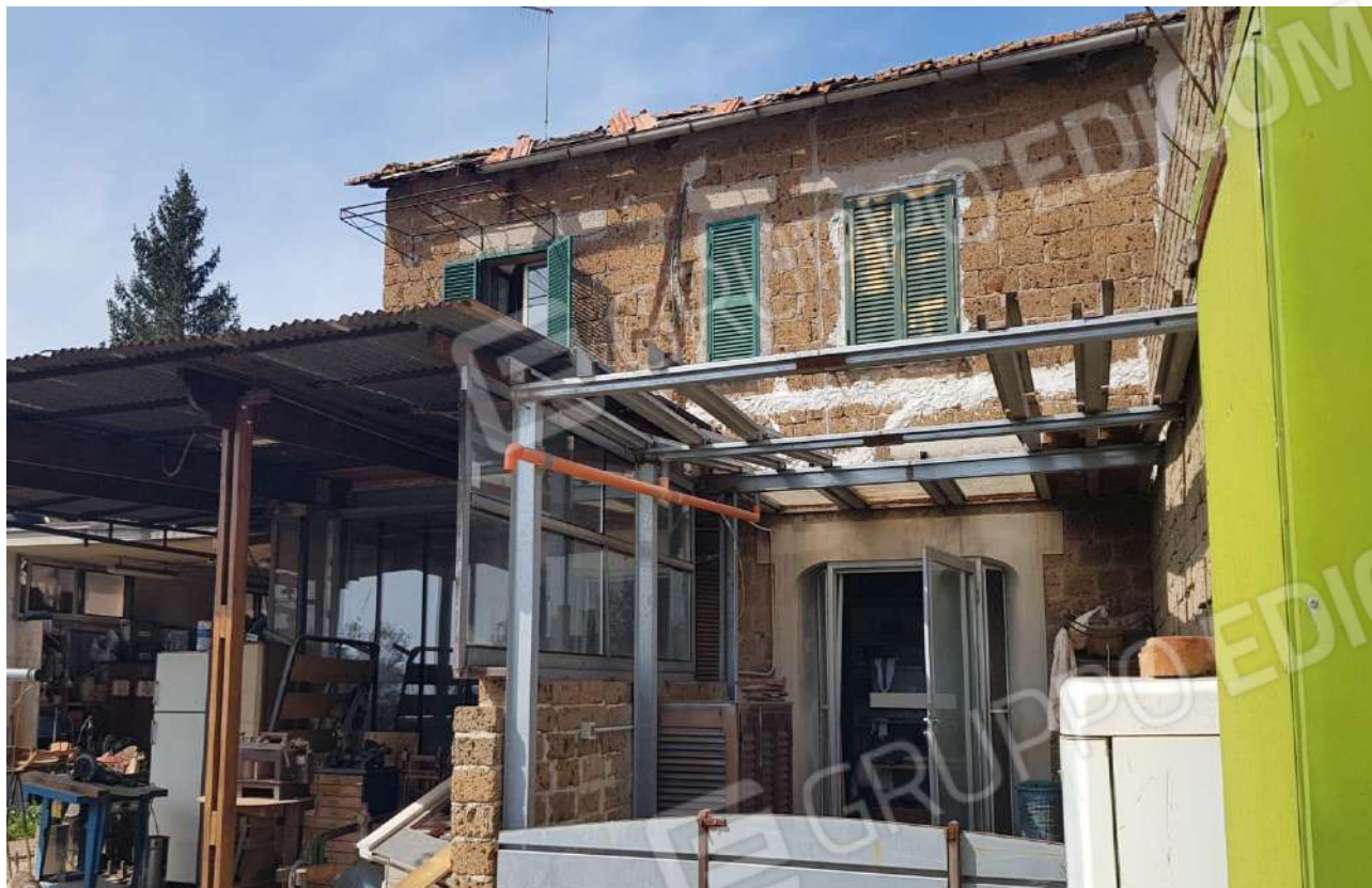
FOTO 3: Veduta esterna prospetto posteriore da part. 202
