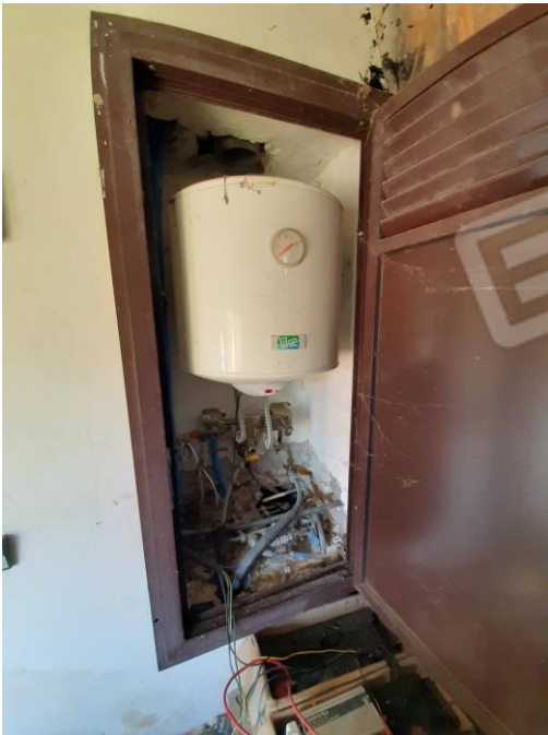
Vano ex alloggio caldaia, oggi occupato da scaldabagno elettrico
