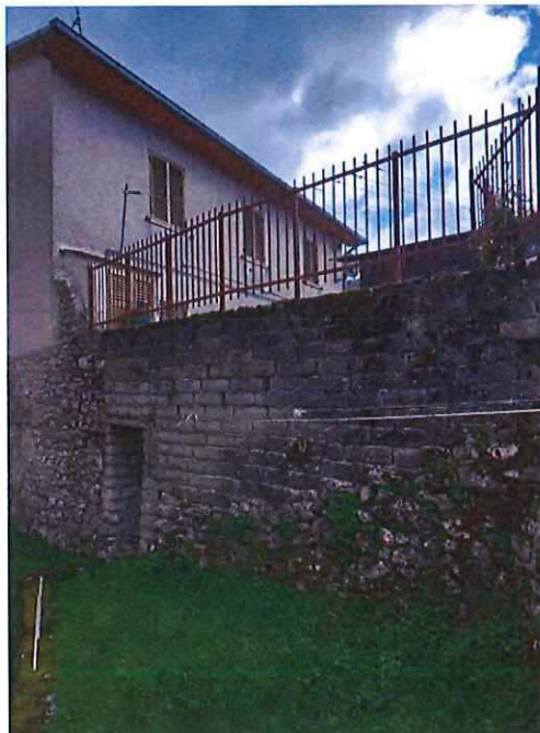
Foto 6 – locale di sgombero esterno
