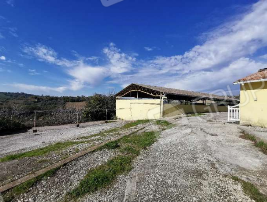
Foto 30 – P.Ila 293 – Prospetto Sud-Est
