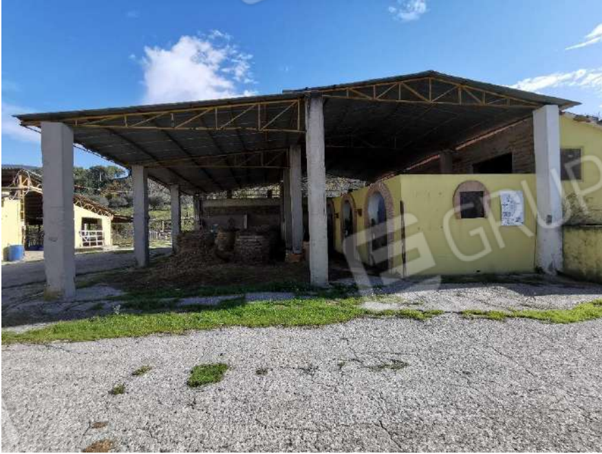
Foto 24 – P.Ila 292 – Prospetto Ovest
