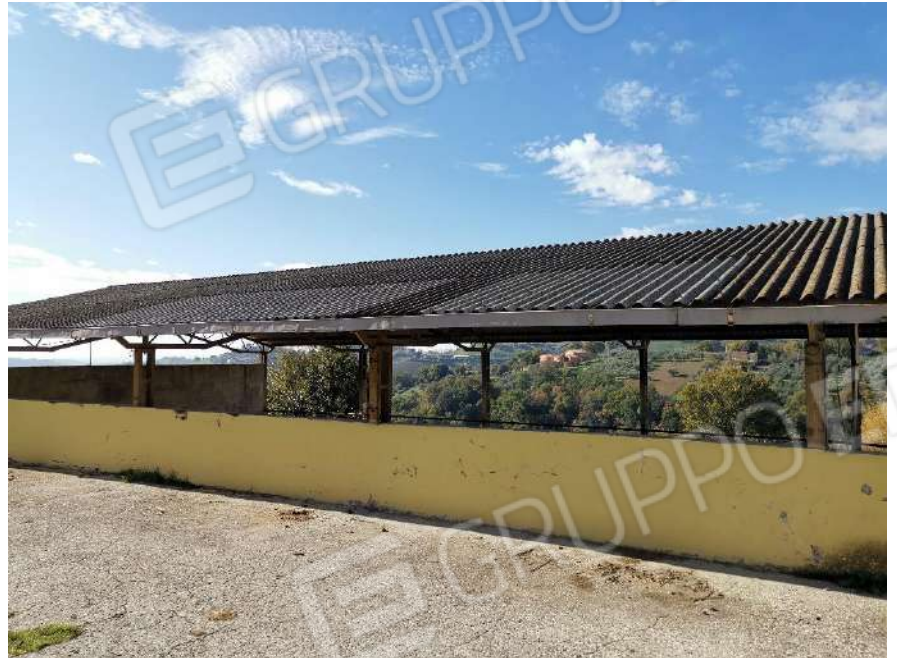
Foto 31 – P.Ila 292 – Prospetto Est
