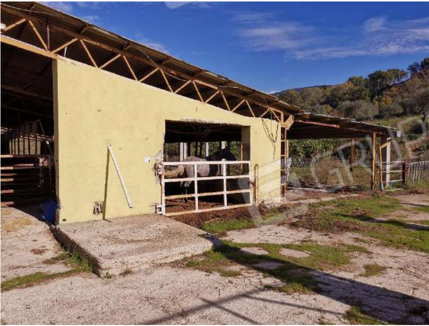
Foto 15 – P.Ila 291 – Prospetto Sud
