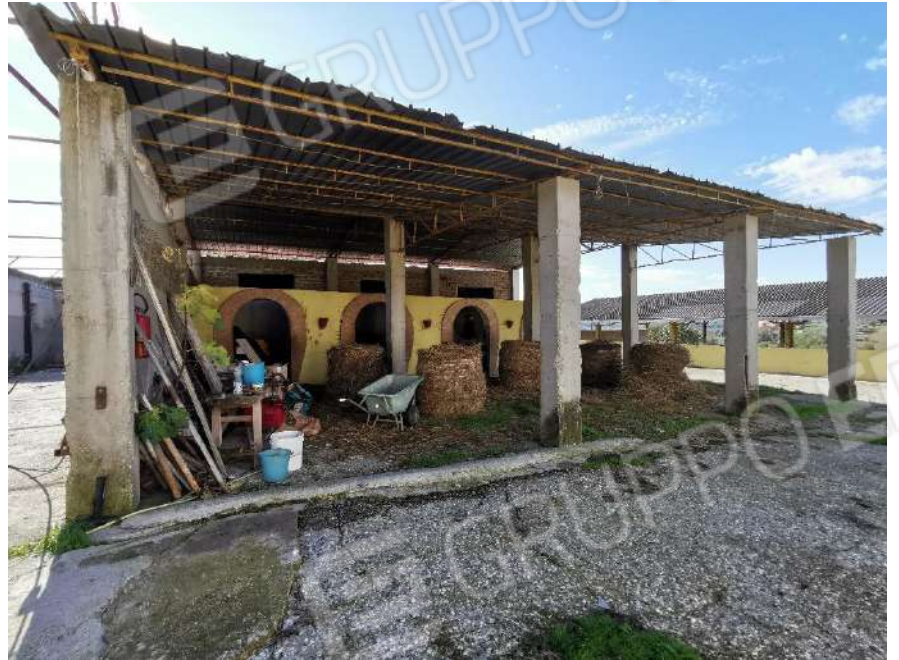
Foto 25 – P.Ila 292 – Prospetto Nord
