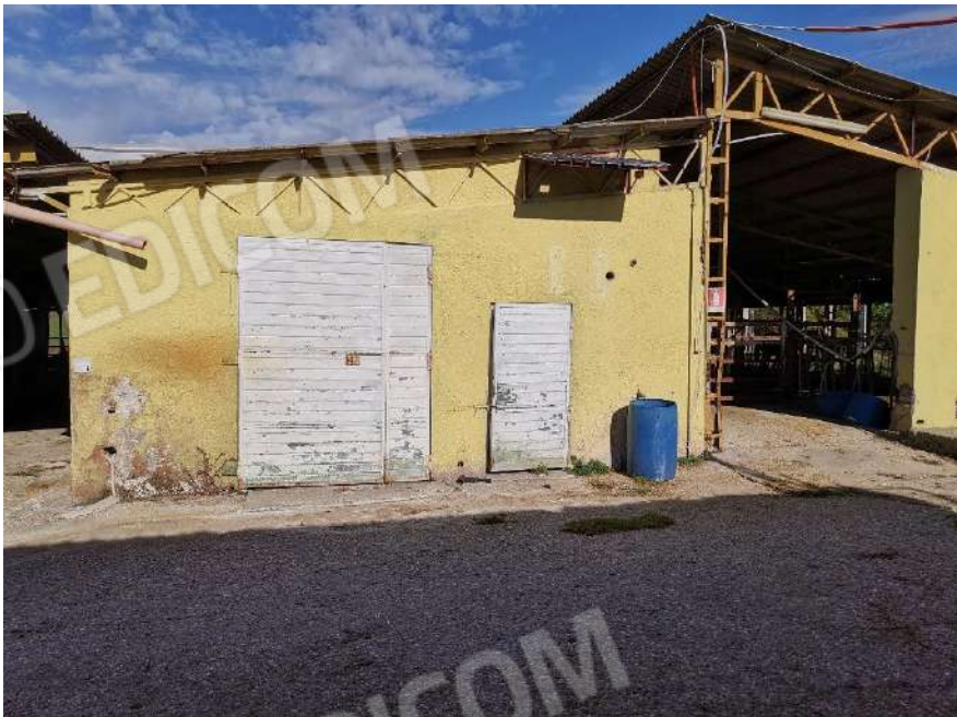
Foto 13 – P.Ila 291 – Prospetto Sud
