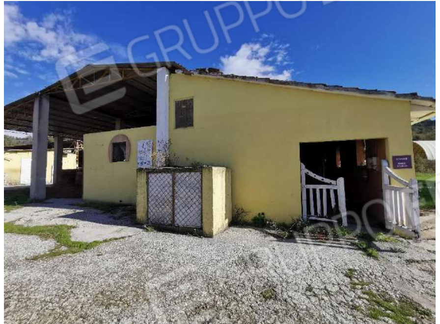
Foto 22 – P.Ila 292 – Prospetto Ovest
