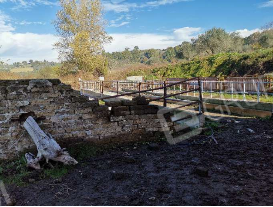
Foto 36 e 37 - P.Ila 301 – Recinti
