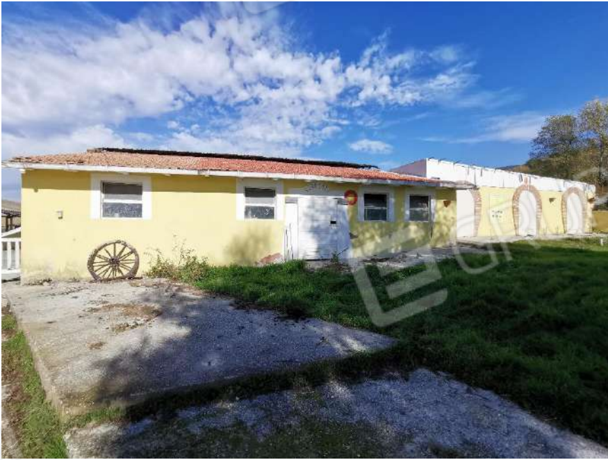
Foto 21 – P.Ila 292 – Prospetto Sud
