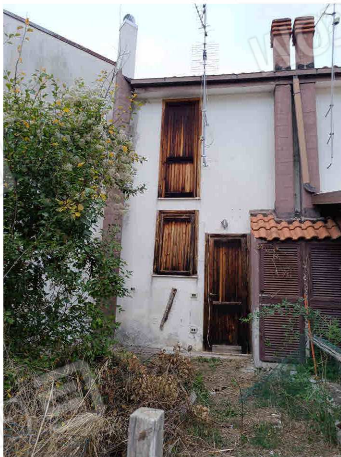
Foto n. 3 – Prospetto accesso fabbricato
