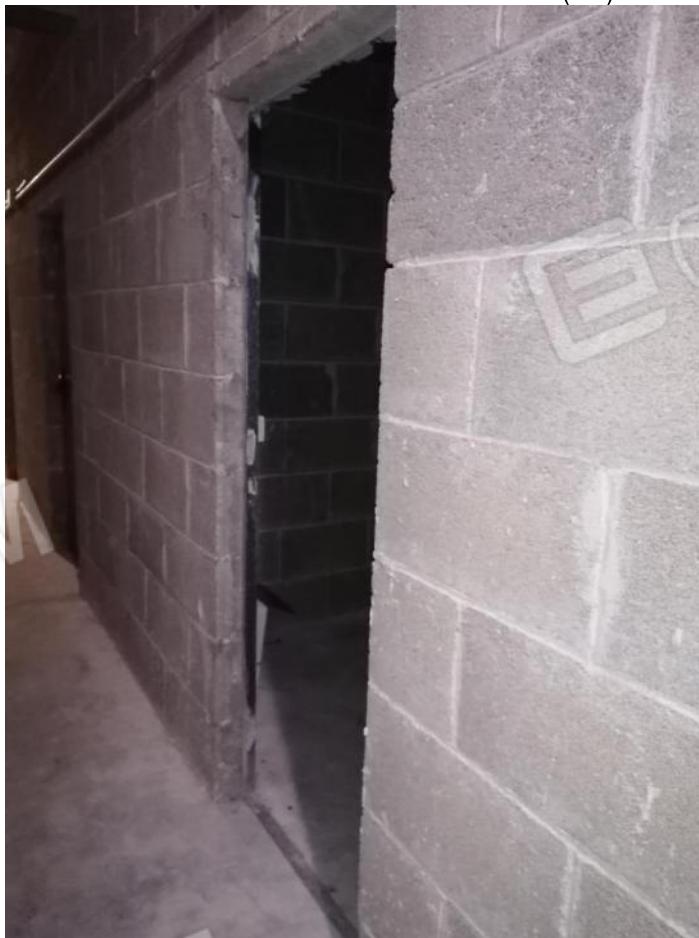
FOTO N°12: Vista esterna della cantina (2/2).
