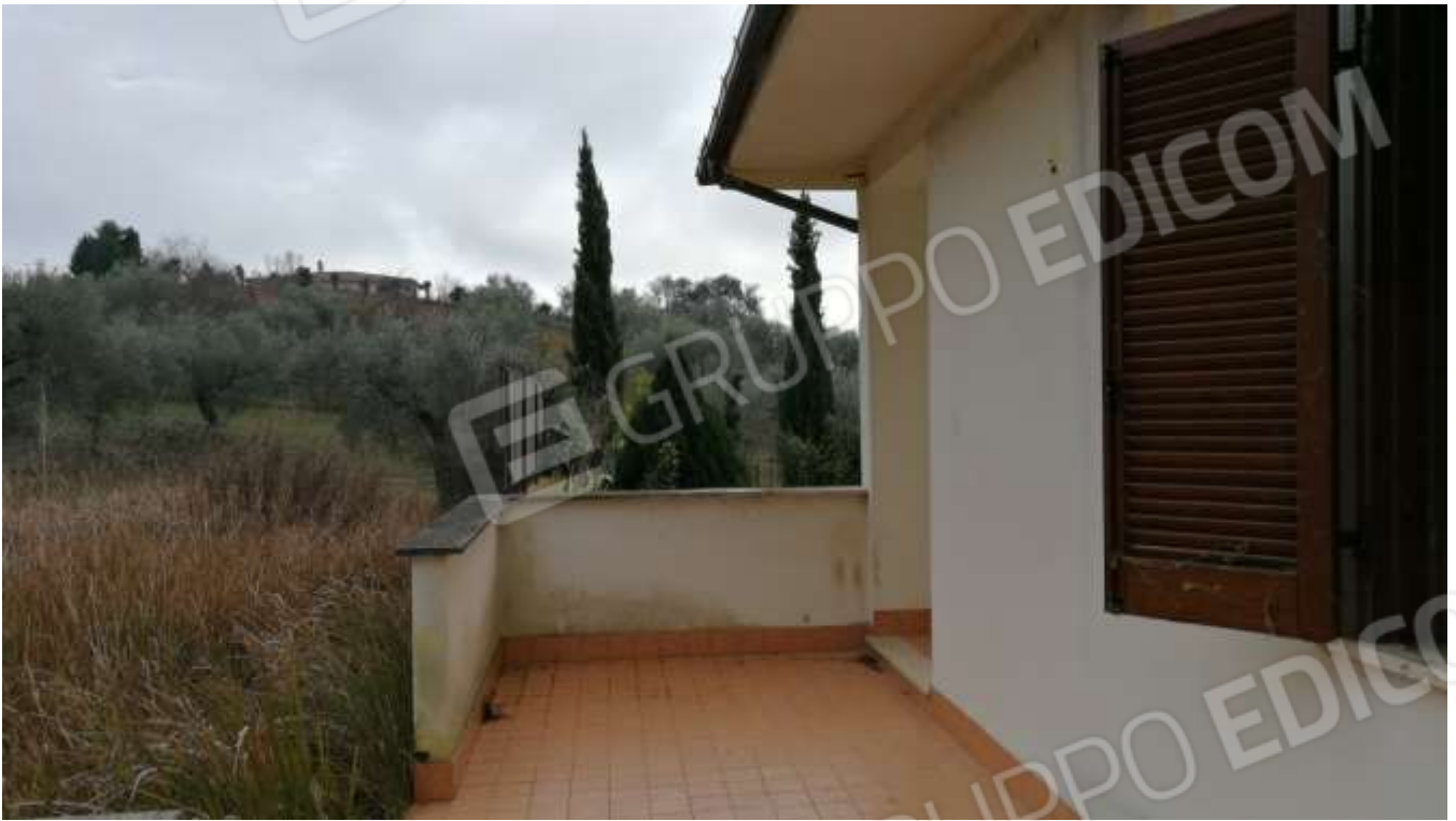
FOTO 07 – LASTRICO SOLARE (Sub. 536)
