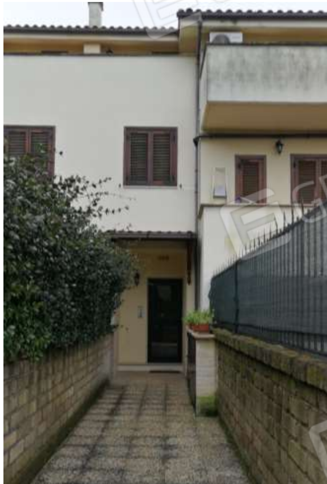
FOTO 02 – Vista Esterna (ingresso condominiale)
