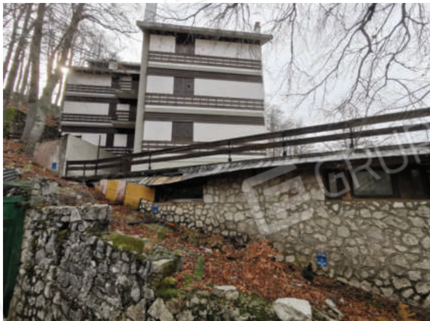
Foto 3 – Prospetto lato nord-est
