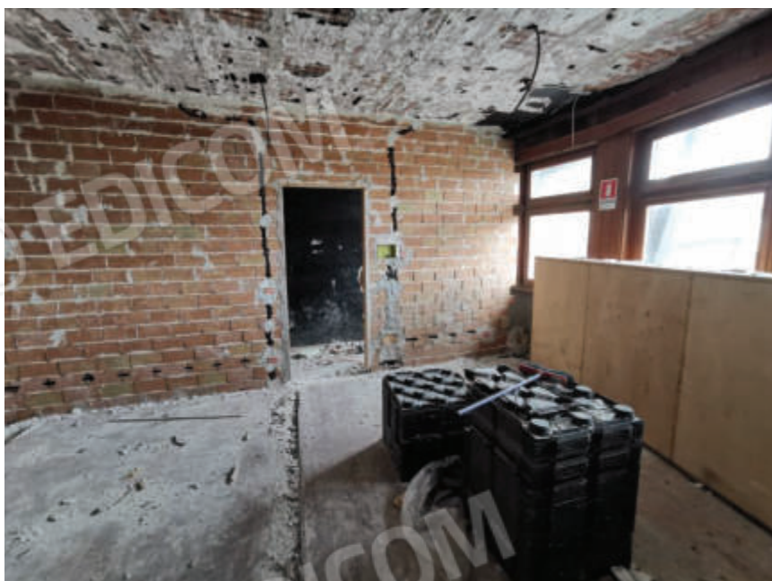
Foto 23 – Piano terra, Vista interna
