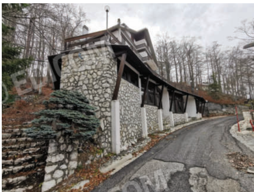
Foto 5 – Prospetto lato nord
