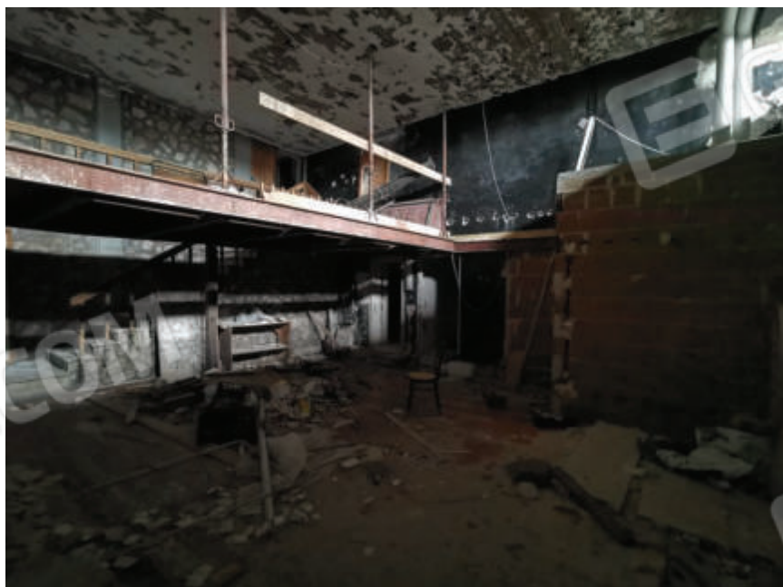
Foto 13 – Piano terra, Vista interna
