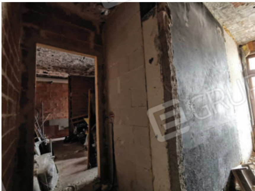
Foto 9 – Piano terra, Vista interna
