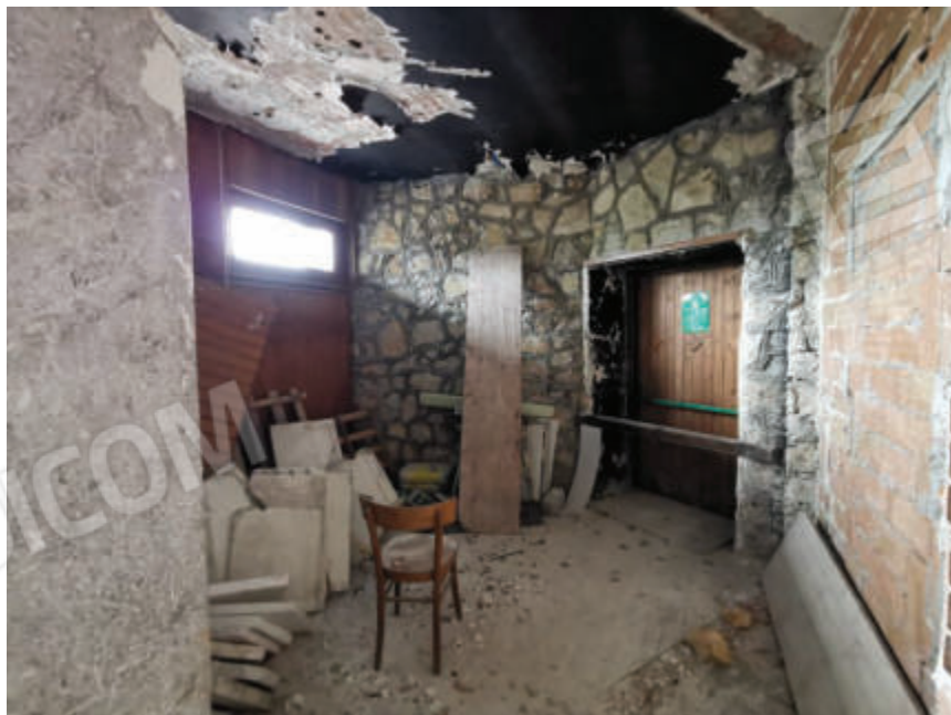
Foto 24– Piano terra, Vista interna
