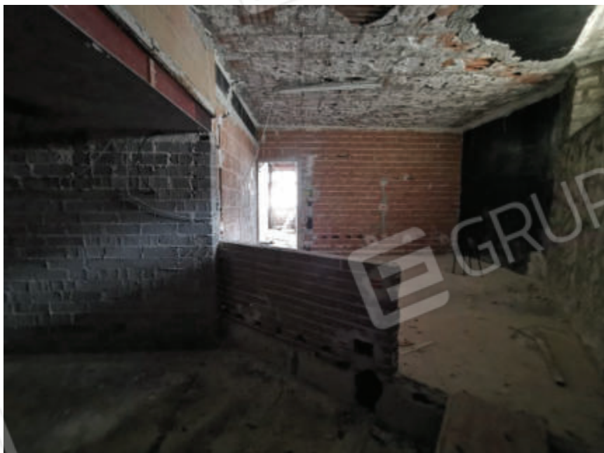
Foto 27 – Piano terra, Vista interna
