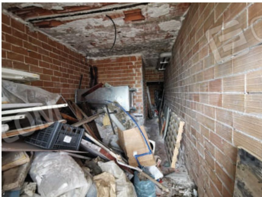
Foto 7 – Piano terra, Vista interna
