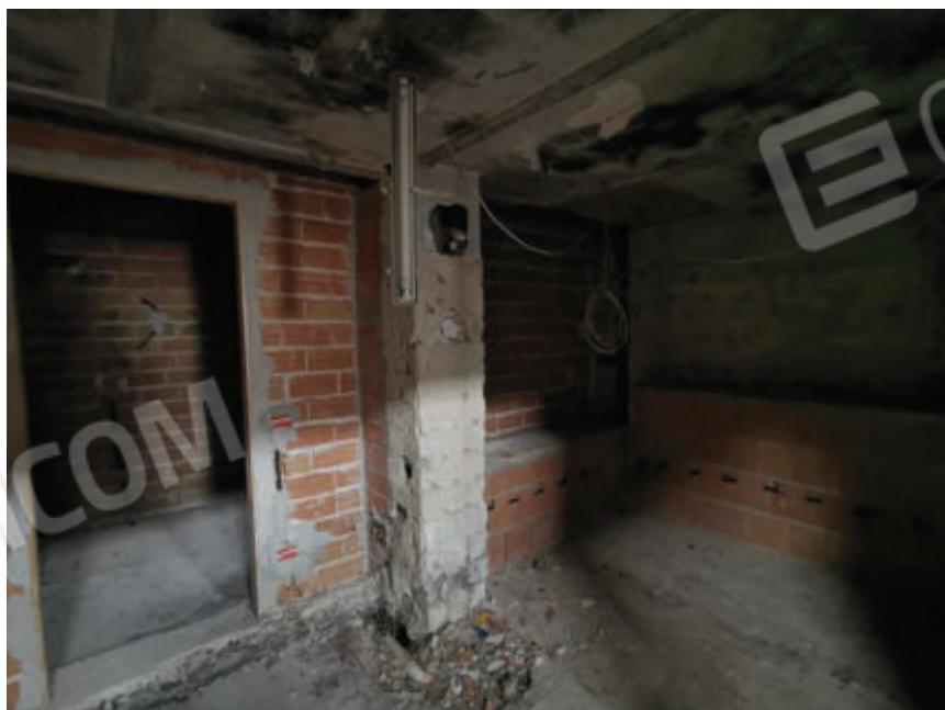
Foto 19 – Piano terra, Vista interna
