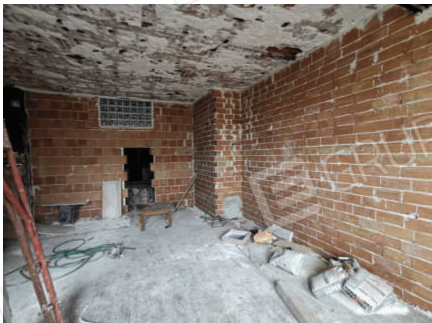
Foto 21 – Piano terra, Vista interna
