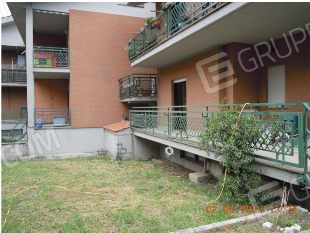
FOTO 8 BALCONE LATO EST
