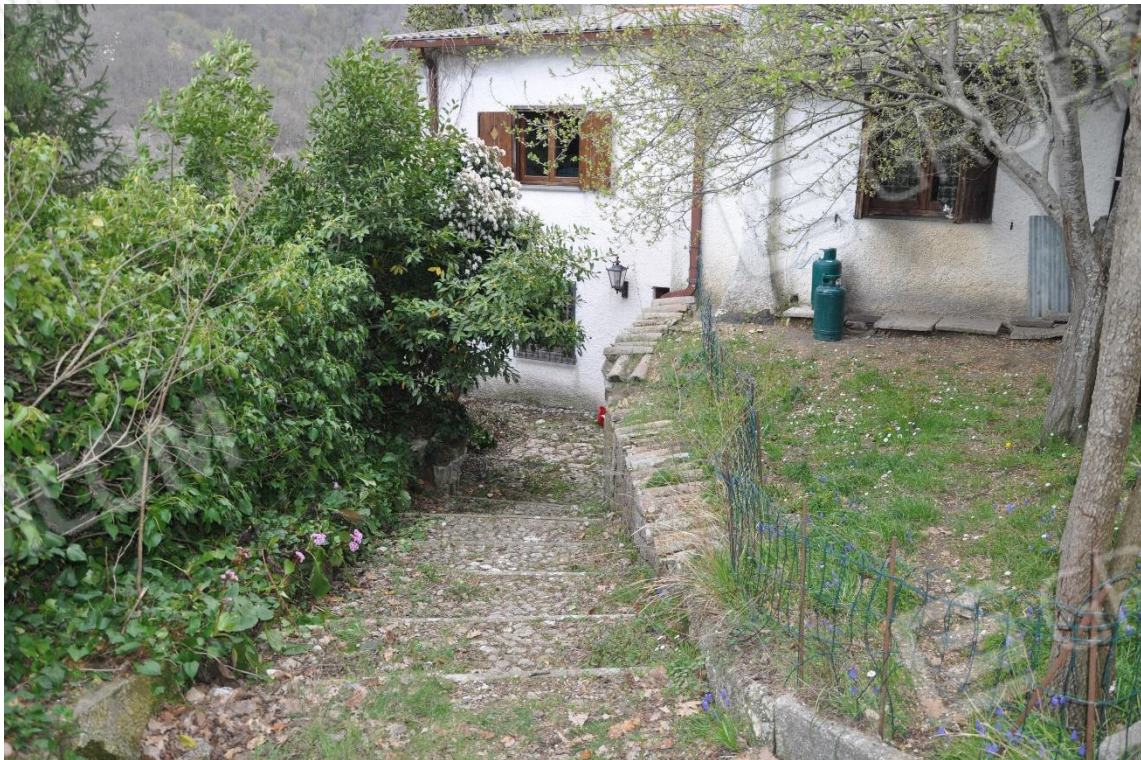
LOTTO UNICO – Fotografia n.3 - Il fronte Est del fabbricato con la visuale del percorso di accesso al Piano seminterrato della abitazione.
