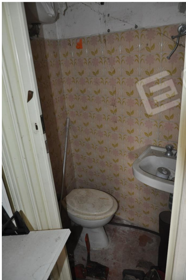
LOTTO UNICO – Fotografia n.13 - Piano Terra dell'Accessorio – L'Ambiente W.c..
