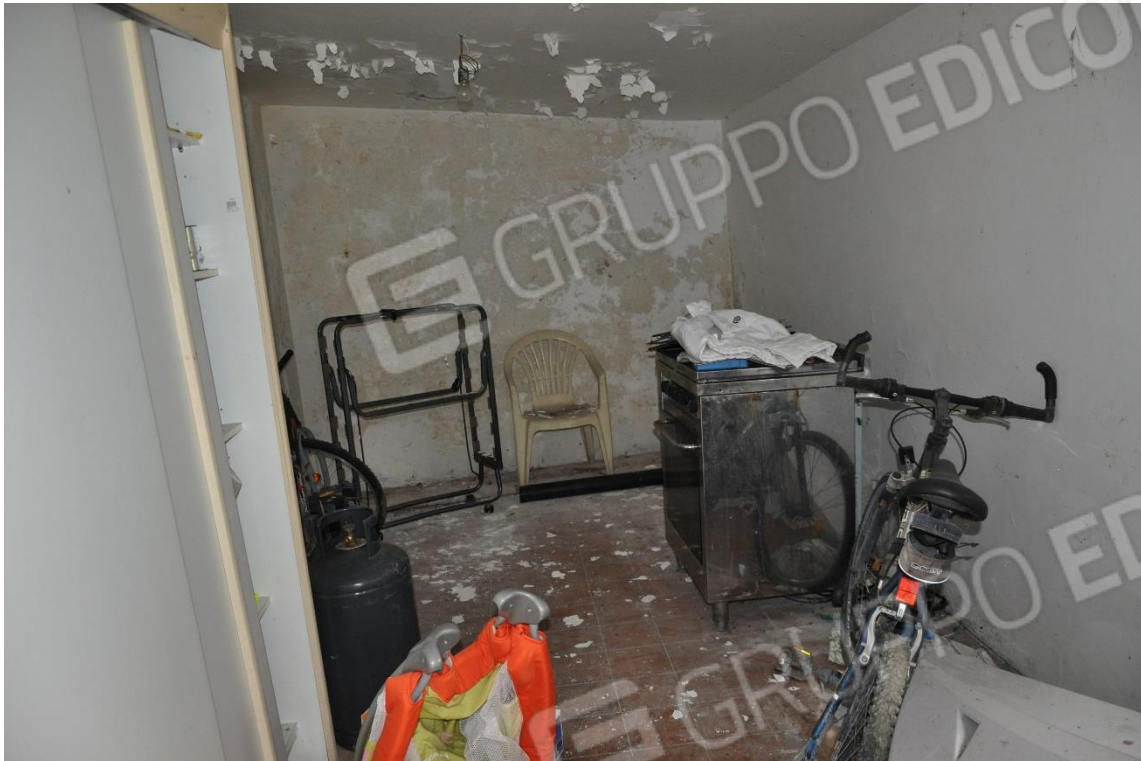
LOTTO UNICO – Fotografia n.12 - Piano Terra dell'Accessorio – L'Ambiente Cantina.
