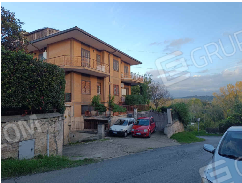
Foto n. 1 – Prospetto del fabbricato su via Flavia
