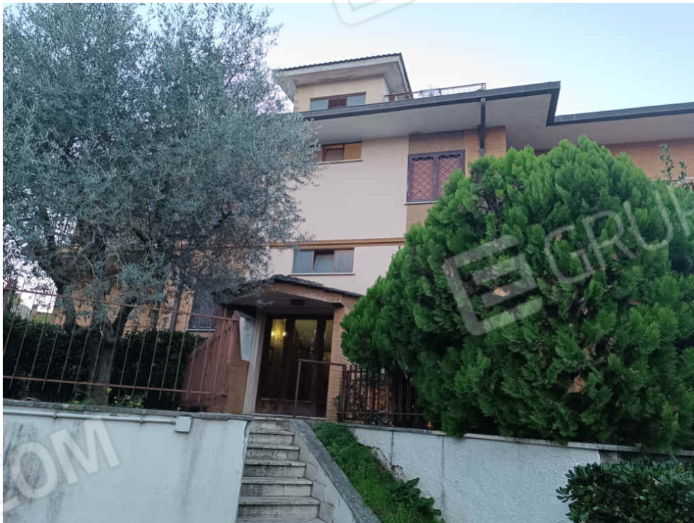
Foto n. 3 – Prospetto accesso all'appartamento
