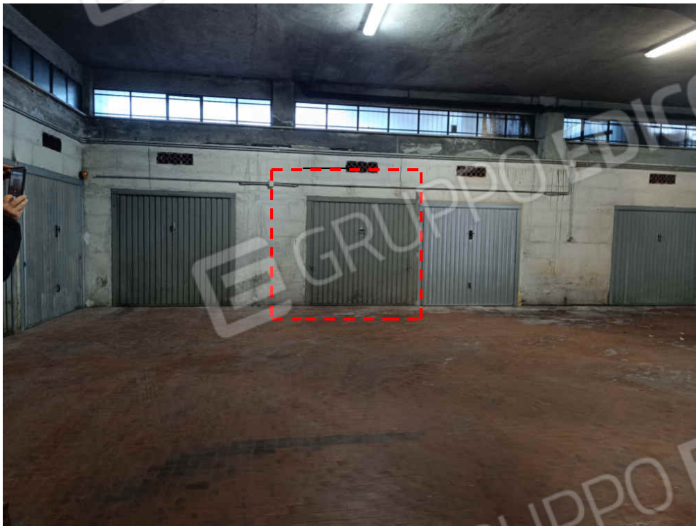
Foto n. 4 – Box al piano seminterrato
