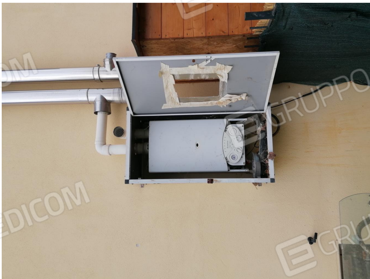
FOTO 14 Caldaia murale esterna
